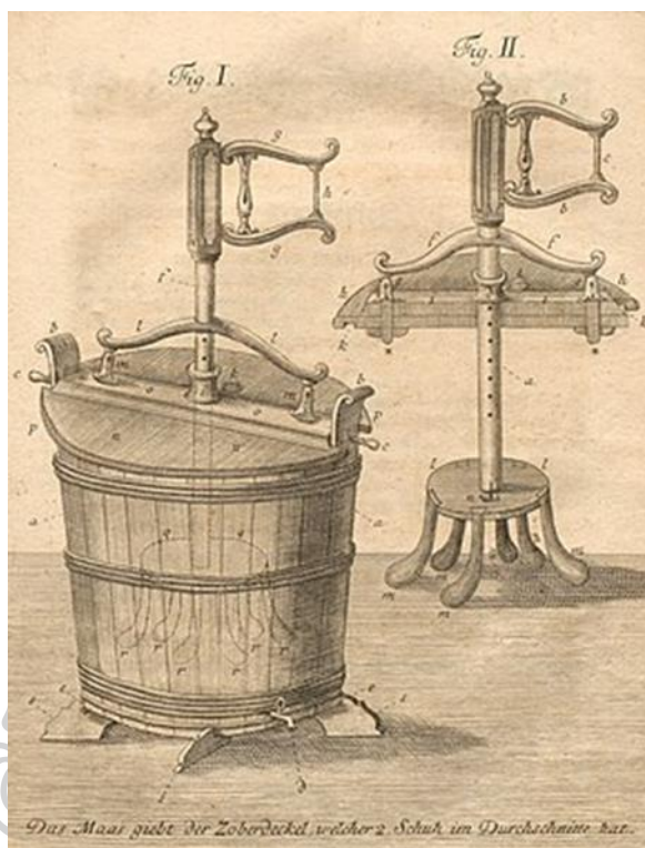
รูปที่ 21 เครื่องซักผ้าฉบับปรับปรุงของ Schaffer ที่มา: Deutsches Museum
