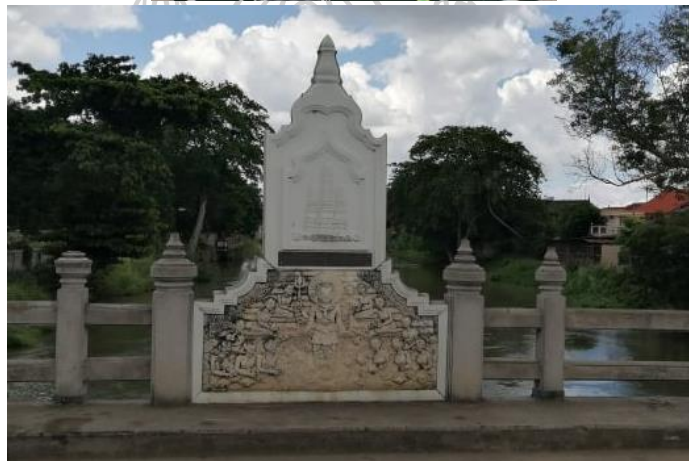
ภาพที่ 50 (ซ้าย) แผ่นป้ายให้ข้อมูลเกี่ยวกับสะพานข้ามแม่น้ำเพชรบุรีที่ตั้งไว้บริเวณสะพาน ภาพที่ 51 (ขวา) ผลงานศิลปกรรมที่สะพานข้ามแม่น้ำเพชรบุรี
