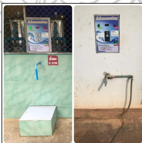
ภาพที่ 4 ตู้น้ำดื่มหยอดเหรียญอัตโนมัติรูปแบบที่สอง ชนิดมีการต่อท่อจ่ายน้ำ ออกมาจากตัวอาคาร ไม่มีช่องจ่ายน้ำ
