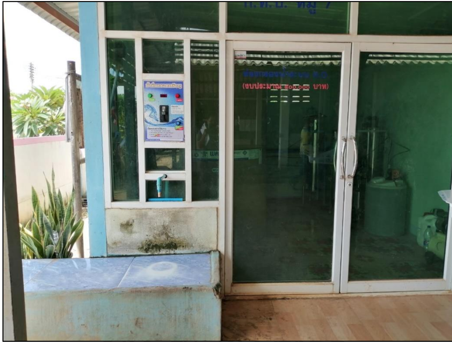
ภาพที่ 6 ตู้น้ำดื่มหยอดเหรียญอัตโนมัติที่มีการติดตั้งแทนวางภาชนะบรรจุในระดับความสูงที่ไม่เหมาะสม
