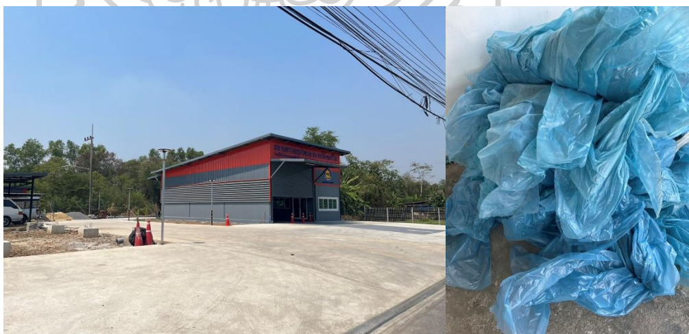
ภาพที่ 43 พื้นที่ก่อสร้างและเศษขยะพลาสติก
