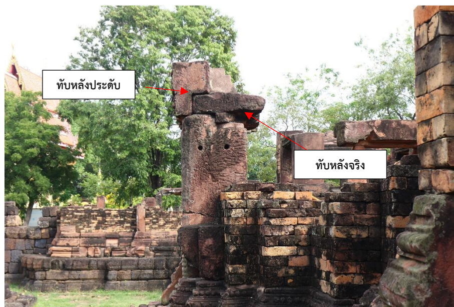
ภาพที่ 76 โครงสร้างทับหลังจริงและทับหลังประดับ
