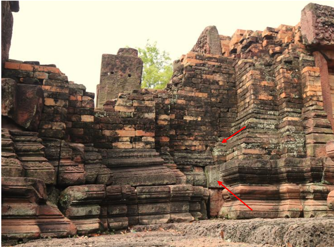
ภาพที่ 51 รอยเชื่อมระหว่างปราสาทประธานหลังกลางและมณฑป
