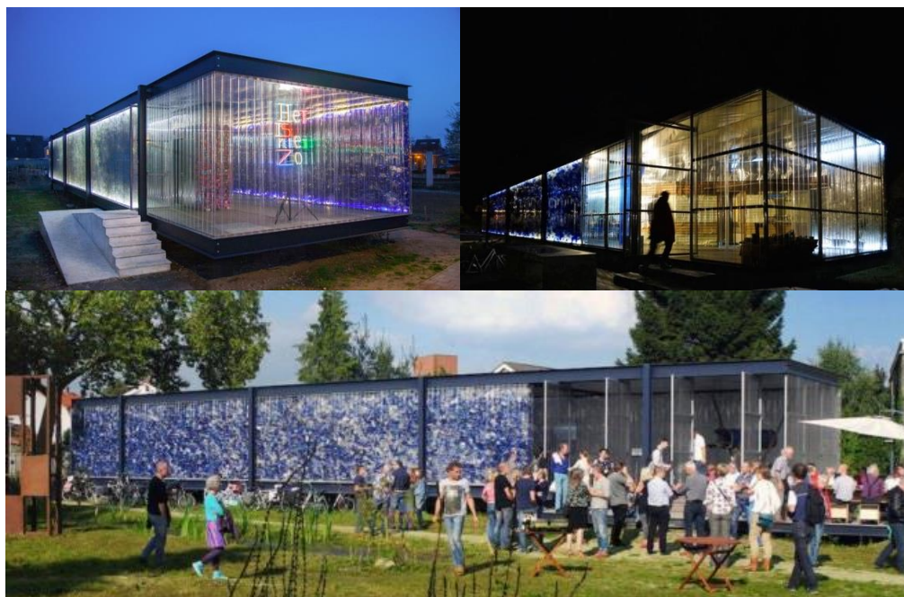
ภาพที่ 69 แสดงแบบโครงการ The pet pavilion, Netherlands
