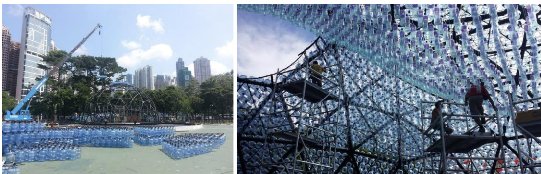
รูปที่ 76 แสดงการก่อสร้างโครงการ Rising Moon, China (Hong Kong)
