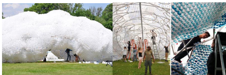
ภาพที่ 135 แสดงโครงการ Head in the Clouds ตัวอย่างการก่อสร้างเฉพาะโครงการ
