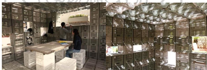
ภาพที่ 136 แสดงโครงการ Emergency Shelter ECS-p1 ตัวอย่างการก่อสร้างแบบง่าย
