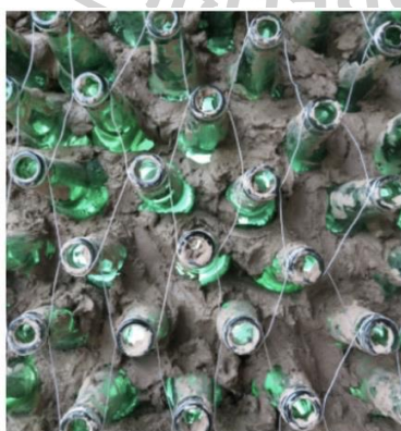
ภาพที่ 43 แสดงวิธีการก่อสร้างโครงการ Li Rongjun office, China ที่มา https://inhabitat.com/this-aspiring-architect-built-his-office-using-8500-beer-bottles/
