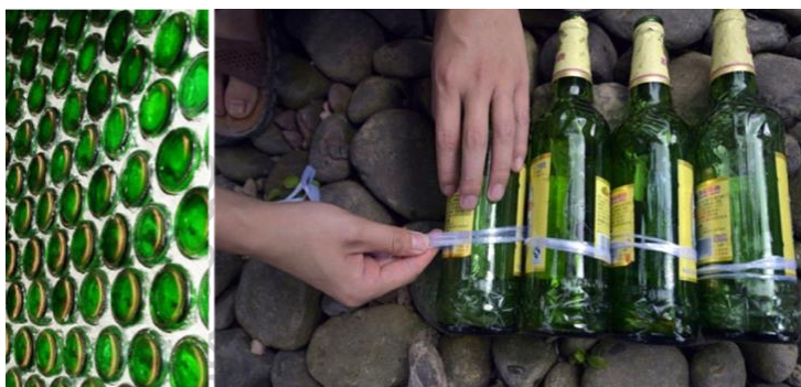
ภาพที่ 42 แสดงการทดลองเพื่อค้นหาวิธีการเชื่อมต่อวัสดุโครงการ Li Rongjun office, China ที่มา https://inhabitat.com/this-aspiring-architect-built-his-office-using-8500-beer-bottles/
