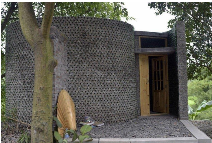
ภาพที่ 40 แสดงภายนอกโครงการ Li Rongjun office, China
