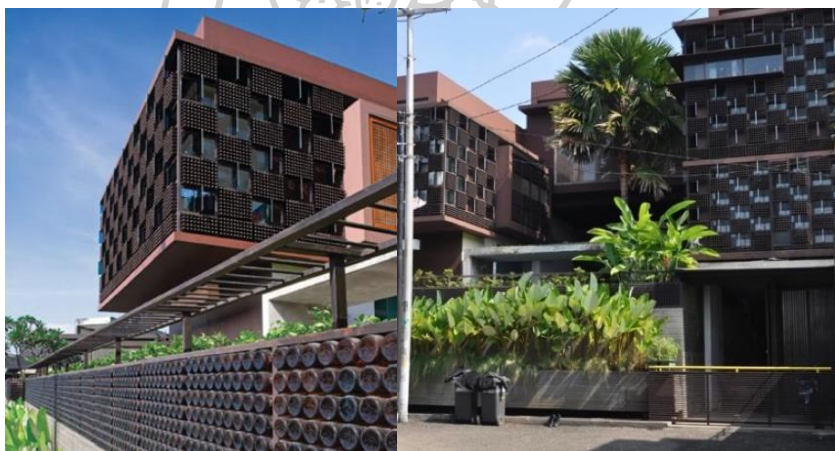
ภาพที่ 31 แสดงภายนอกอาคารของโครงการ Bottle house, Indonesia
