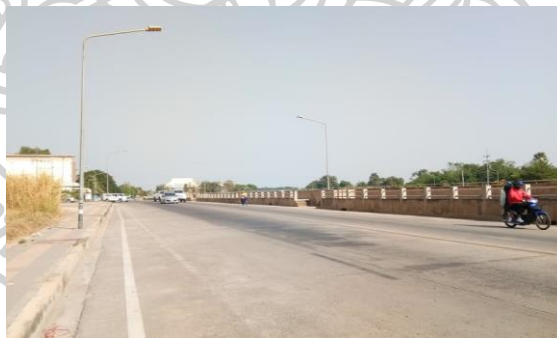
ภาพ 76 ลักษณะเขื่อนป้องกันน้ำท่วมบริเวณพื้นที่ C (ไม่มีทางเท้าริมถนน)
