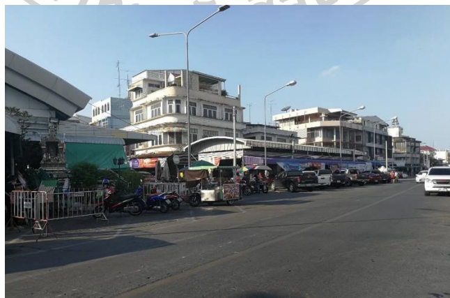
ภาพ 39 โครงสร้างเหล็กถาวรข้างตลาดสดเทศบาล ตรงข้ามเขื่อนป้องกันน้ำท่วม
