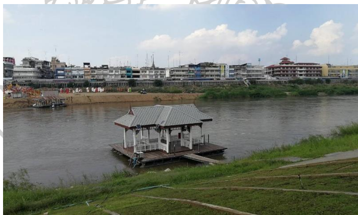
ภาพ 34 บริเวณท่าเรือ พาสาน จังหวัดนครสวรรค์ มองเข้าไปยังโครงการเขื่อนป้องกันน้ำท่วม
