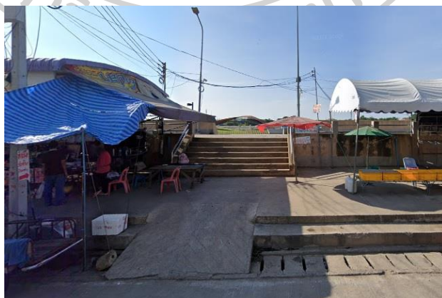
ภาพ 55 ทางลาดและบันไดบริเวณพื้นที่ B (ใกล้ตลาดเก่าปากน้ำโพ) เพื่อลงไปยังอัมพันจันทรลานหาดทรายริมเขื่อนป้องกันน้ำท่วม
