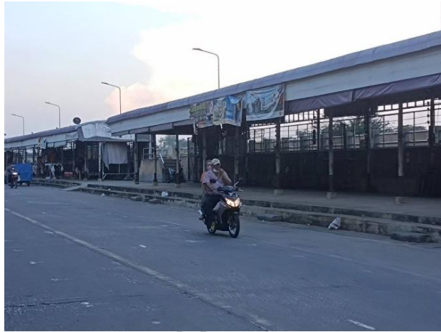
ภาพ 53 โครงสร้างเหล็กร้านค้าบริเวณพื้นที่ B
