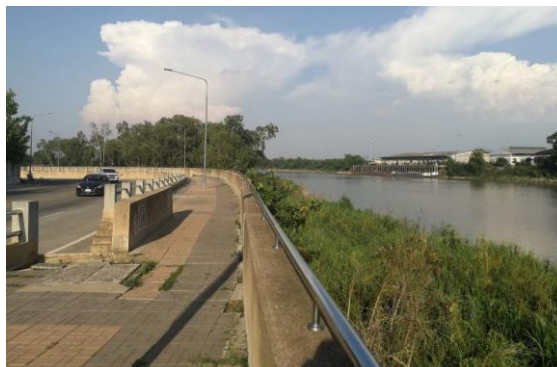
ภาพ 77 ทางเดินบนสันเขื่อน บริเวณพื้นที่ C
