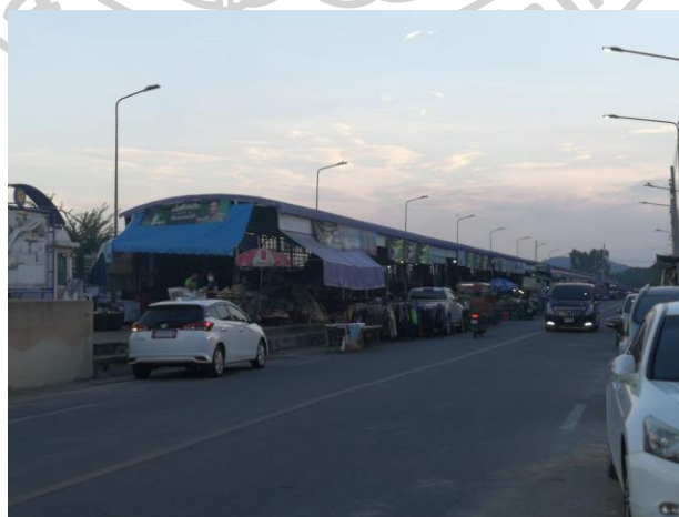
ภาพ 66 โครงสร้างเหล็กร้านค้าพื้นที่ C
