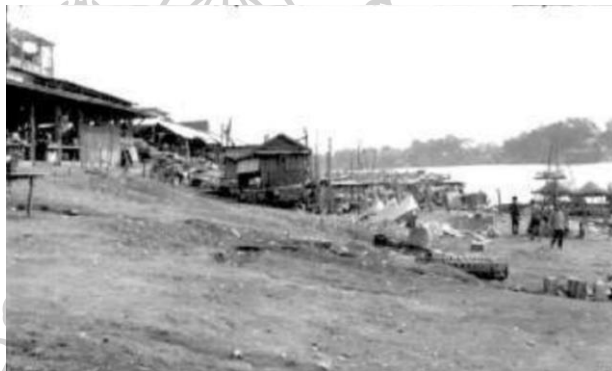
ภาพ 19 ทางลาดริมแม่น้ำเจ้าพระยา เพื่อเป็นที่ขึ้นเรือ (ที่มา: ภาพเก่าเล่าอดีตปากน้ำโพ)
