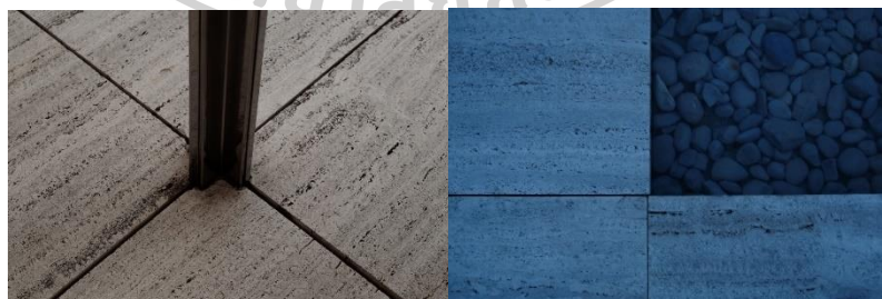
ภาพที่ 38 แสดงรอยต่อเสาเหล็กและหินอ่อน บาร์เซโลนา พาวิลเลียน
