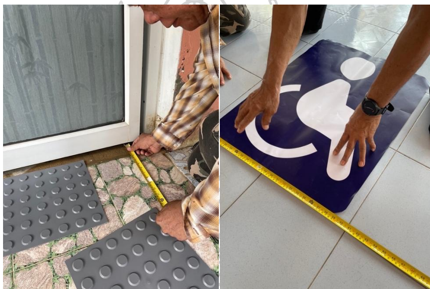
ภาพที่ 126 ติดตั้งแผ่นยางเตือนสำหรับผู้พิการทางสายตาและfoot Printจราจรเข็นคนพิการ
