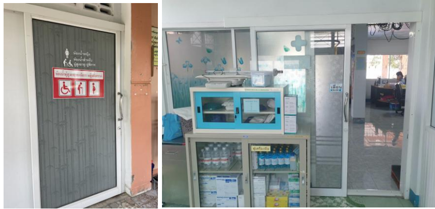
ภาพที่ 67 การใช้ประตูแบบเลื่อนช่วยในการผ่อนแรง
