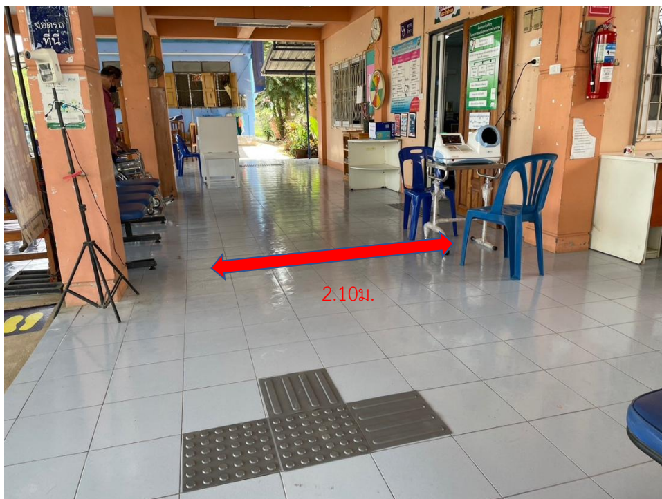
ภาพที่ 128 ปรับพื้นที่ทางเข้าด้านหน้า
