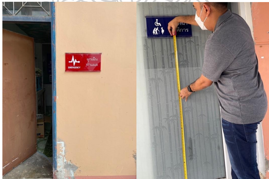
ภาพที่ 122 ติดตั้งระบบป้ายสัญลักษณ์
