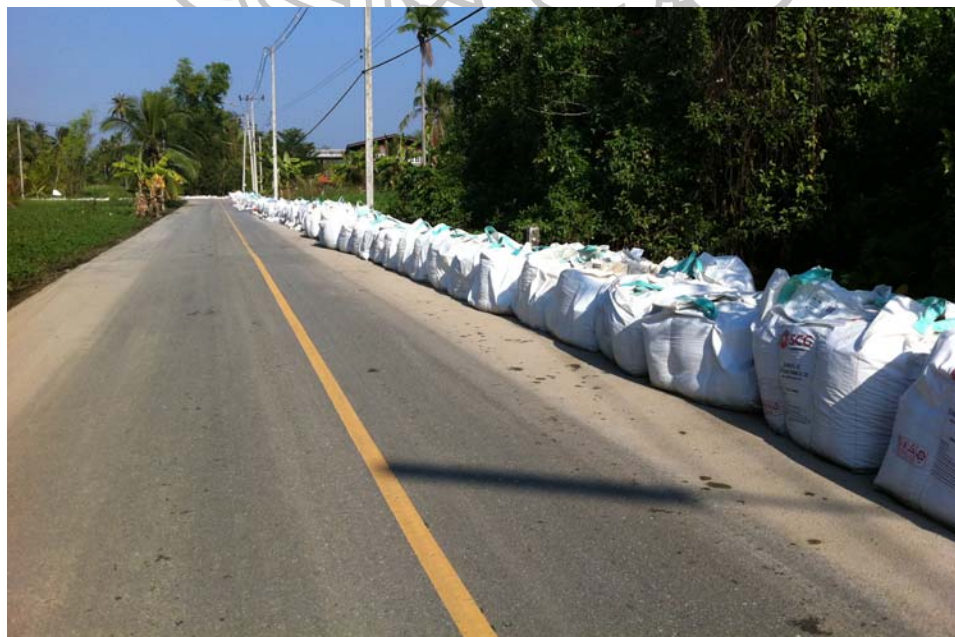
แนวบิ๊กแบ็กป้องกันน้ำท่วมสวนส้มโอพื้นที่ตำบลบางเตยและตำบลทรงคนอง
