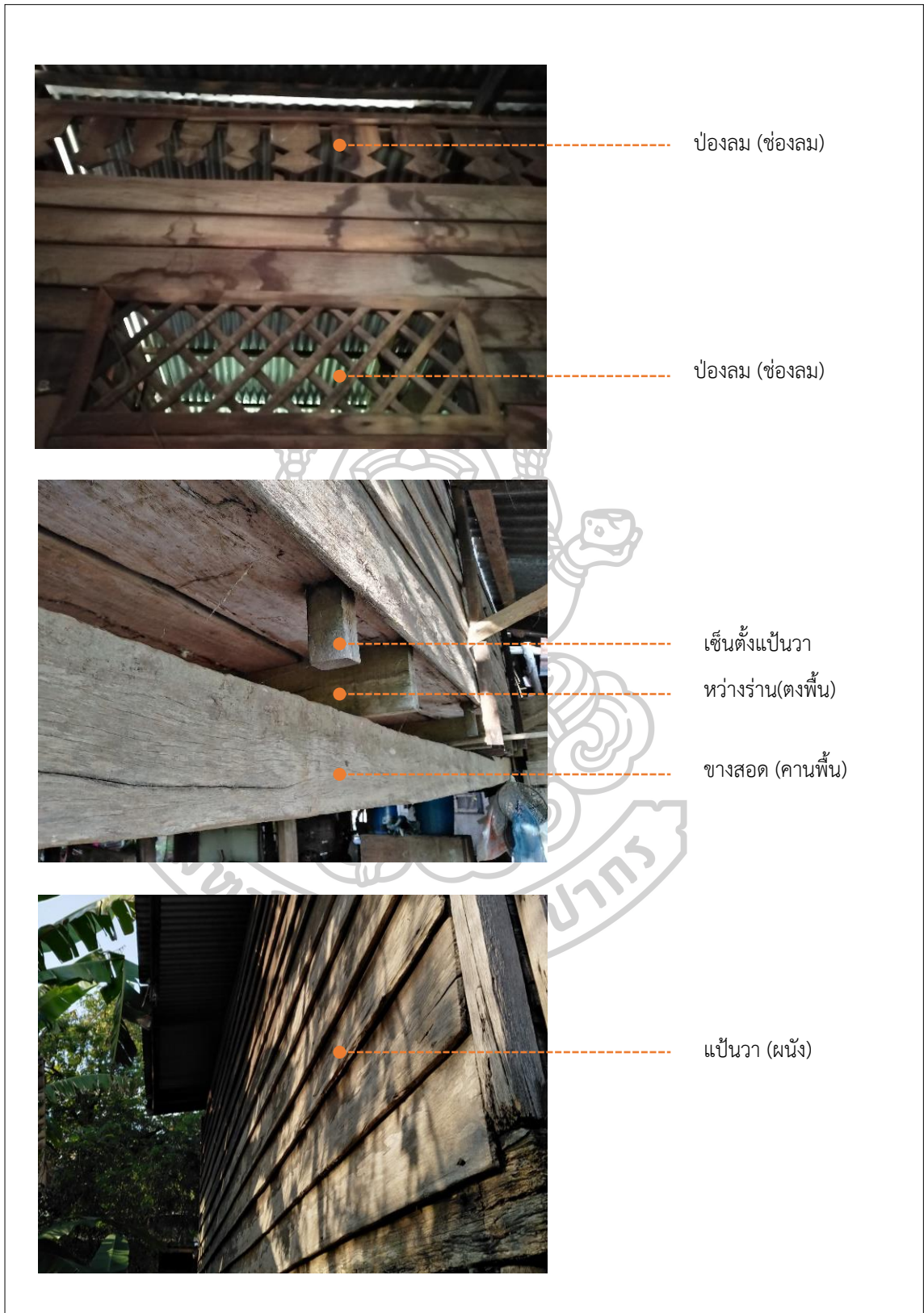
ภาพที่ 38 แสดงองค์ประกอบโครงสร้างเรือนกรณีศึกษาที่ 1 (T-PL-03A)
