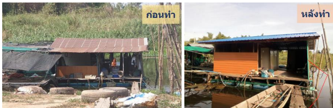
ภาพที่ 55 แสดงเปรียบเทียบก่อน/หลัง ดำเนินการซ่อมแซมฝาเรือนแพ และหลังคา
