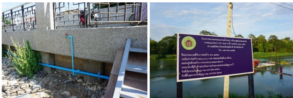
ภาพที่ 34 แสดงกลุ่มกำลังดำเนินการขยายแนวเขต โครงการขยายเขตท่อเมนจ่ายน้ำประปา เทศบาลเมืองอุทัยธานี
