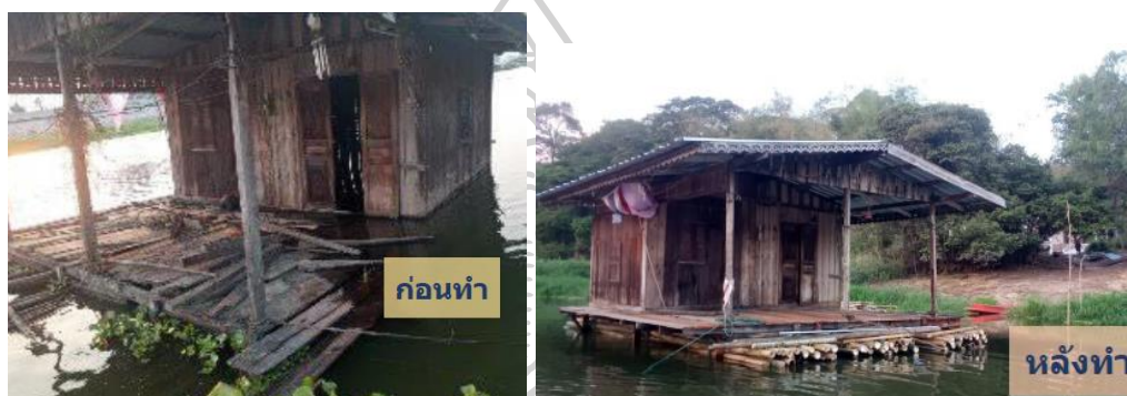
ภาพที่ 55 แสดงเปรียบเทียบก่อน/หลัง ดำเนินการซ่อมแซมฝาเรือนแพ และหลังคา
