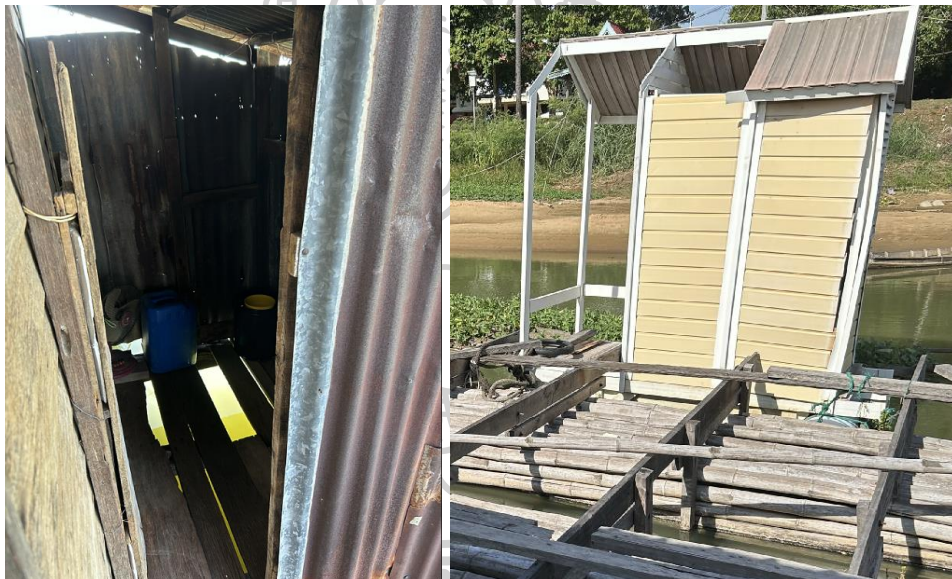
ภาพที่ 36 แสดงระบบส้วมที่ไม่มีระบบบ่อเกรอะ และส้วมที่ไม่สามารถใช้งานได้
