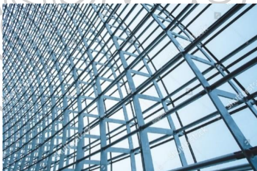
ภาพที่ 62 โครงสร้างเหล็ก (Steel structure system)
