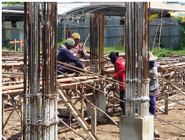
ภาพที่ 22 การพูดคุยกันถึงการติดตั้งงานของคนงาน 27/08/2564
