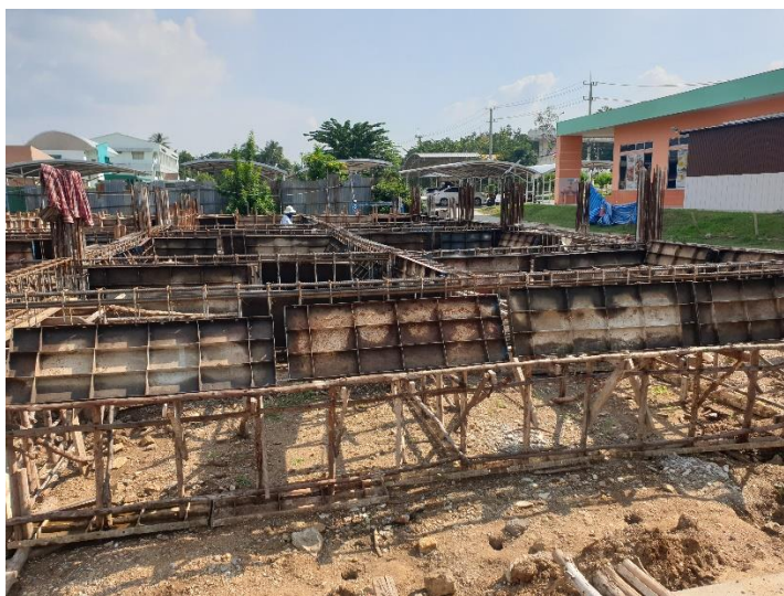
ภาพที่ 33 การวางไม้แบบไว้ข้างคันเตรียมติดตั้ง 18/09/2564
