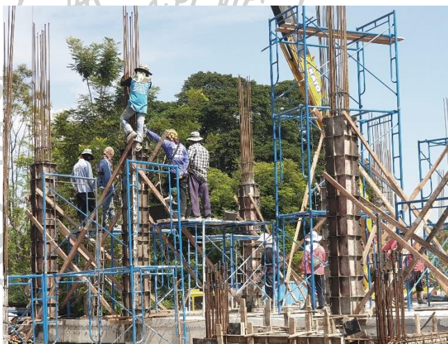
ภาพที่ 48 เทคอนกรีตเสา ชั้น 1 02/11/2564
