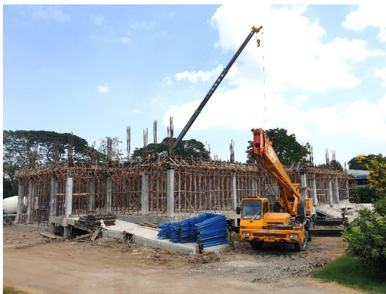
ภาพที่ 50 งานก่อสร้างหุ้ดรอรอปุนที่ซาดช่วงในการเทคอนกริตคาน ชั้น 2 20/01/2565 วันที่ 4 มีนาคม 2565
