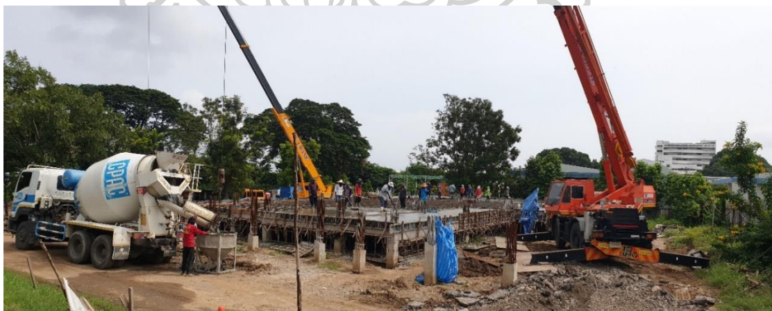
ภาพที่ 46 การใช้เครนสองตัวเทคอนกรีต 22/10/2564
