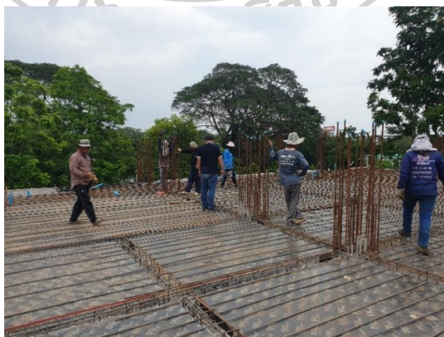
ภาพที่ 26 การทำงานในช่วงก่อนที่ฝนตก 17/02/2565
