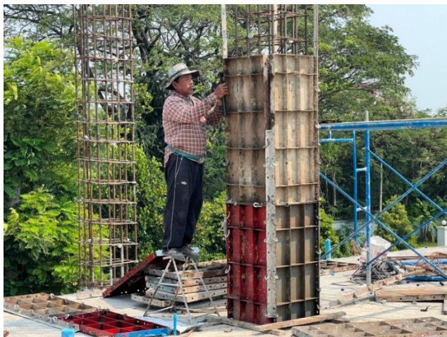
ภาพที่ 39 ประกอบไม้แบบกลับด้าน 02/03/2565
