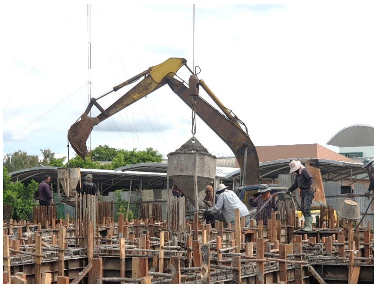
ภาพที่ 44 การใช้แบคโฮแขวนบัคเกิดเทคอนกรีต 24/09/2564
