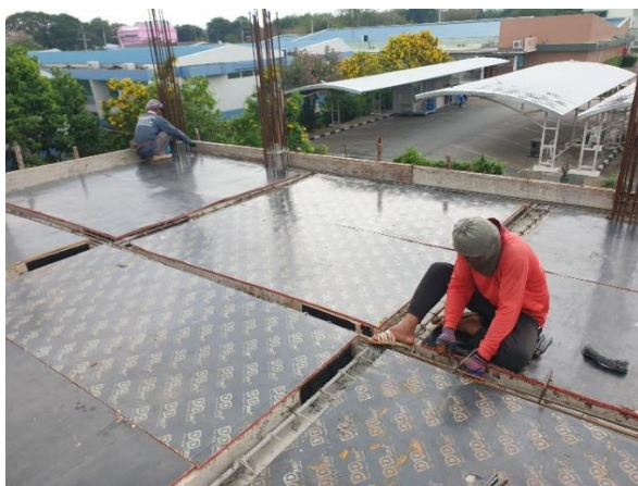
ภาพที่ 25 คนงานกำลังแก้ไขใส่เหล็กเสริมในคานรับพื้นอาคาร 15/02/2565 วันที่ 17 กุมภาพันธ์ 2565
