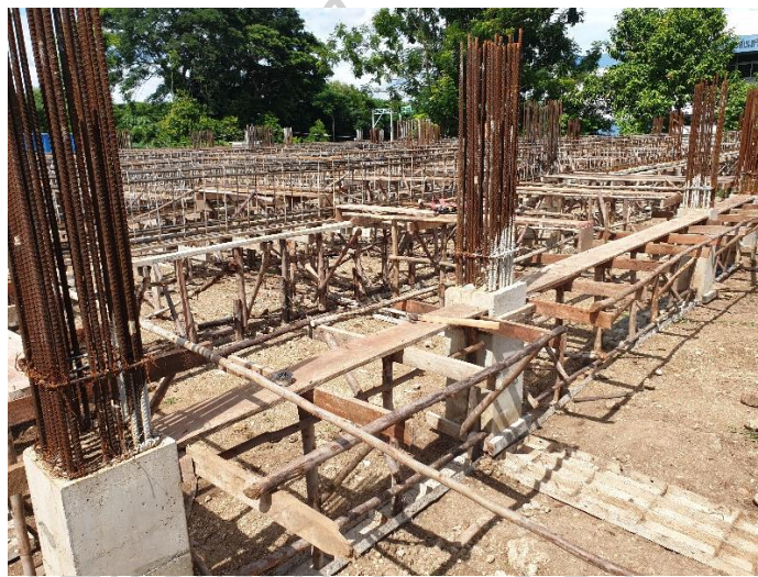
ภาพที่ 31 การวางค้ำยันไม้แบบบนดิน 05/09/2564
