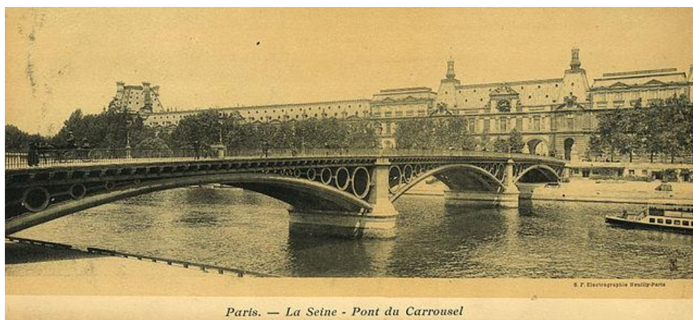
ภาพที่ 15 สะพานเหล็กหล่อในปารีส และใช้คอนกรีตเพื่อสร้างฐานราก (Pont du Carrousel, 1839)
