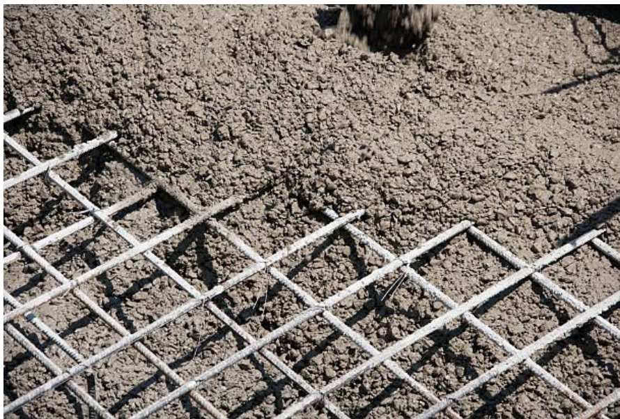
ภาพที่ 62 เทคนิคการเสริมเหล็กด้วยการใช้ลวดตาข่ายเป็นแกน และหล่อ หรือเททับด้วยซีเมนต์หรือที่เรียกว่า “เฟอร์โร-ซีเมนต์ (Ferro-Cement)” ที่มา https://www.istockphoto.com/th/search/2/image?phrase=ferro+concrete
