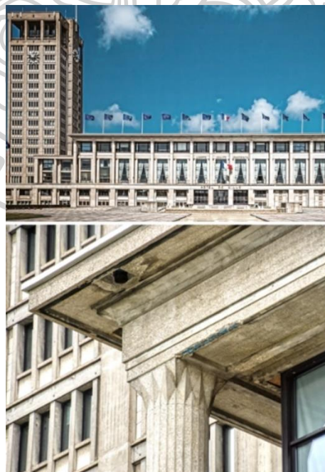
ภาพที่ 55 การออกแบบเสาของอาคารศาลาว่าการ (Column details Place de 1'Hotel de Ville), 1953. ออกแบบโดย ปีแอร์ เอดูอาร์ แลมเบิร์ต (Pierre-Edouard Lambert) ที่มา Google (2020)
