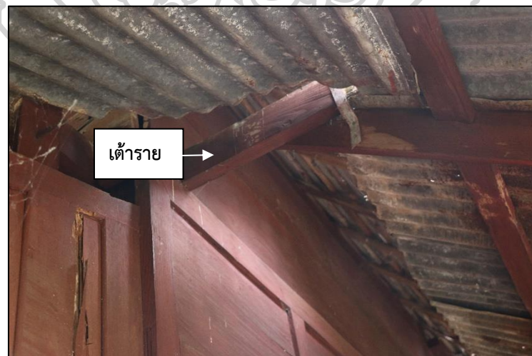
ภาพที่ 93 เต้ารายและจันทันปีกนกรับหลังคากันสาด อุโบสถวัดจันทร์เจริญสุข
