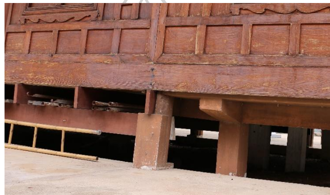
ภาพที่ 19 ตอม่อคอนกรีตอุโบสถวัดคลองกรณ
