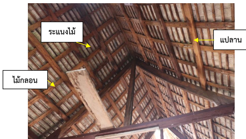
ภาพที่ 84 องค์กรประกอบจันทันและแปตะแคง อุโบสถวัดจันทร์เจริญสุข
