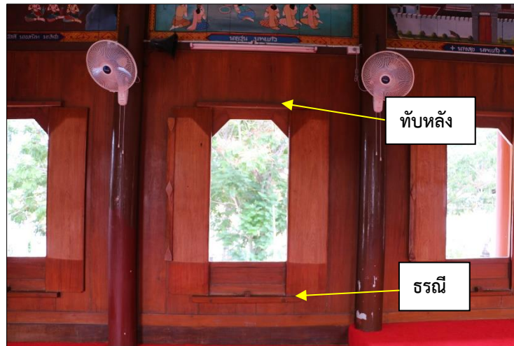
ภาพที่ 65 องค์ประกอบหน้าต่าง อุโบสถวัดบางจะเกร็ง
