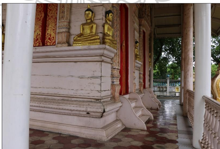
ภาพที่ 48 กระเบื้องดินเผาหกเหลี่ยมปะปนกับกระเบื้องในคราวบูรณะสมัยหลัง อุโบสถวัดแหลมสุวรรณาราม
