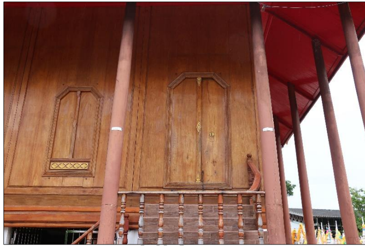
ภาพที่ 75 ประตูด้านข้าง อุโบสถวัดบางจะเกร็ง
