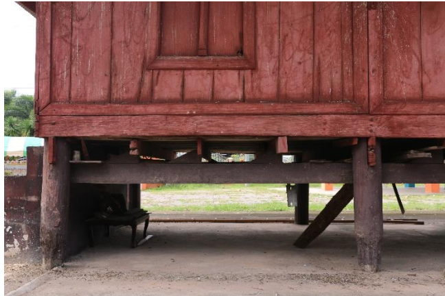
ภาพที่ 11 ใต้ถุนอุโบสถวัดวิมลวรรณคาราม และแนวการกร่อนของเสา
