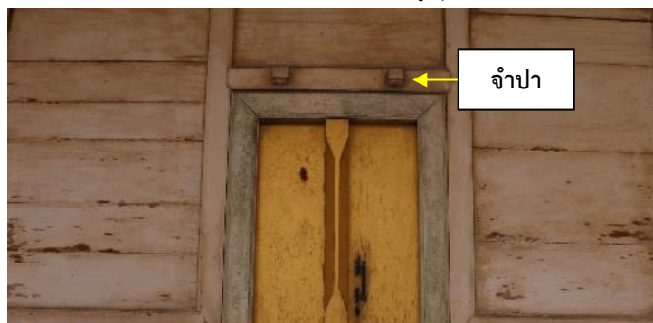
ภาพที่ 68 กรอบเข็ดหน้าและจำปาประตู (ทำเป็นเดือยไม้สี่เหลี่ยม) อุโบสถวัดกลางอ่าแก้ว
