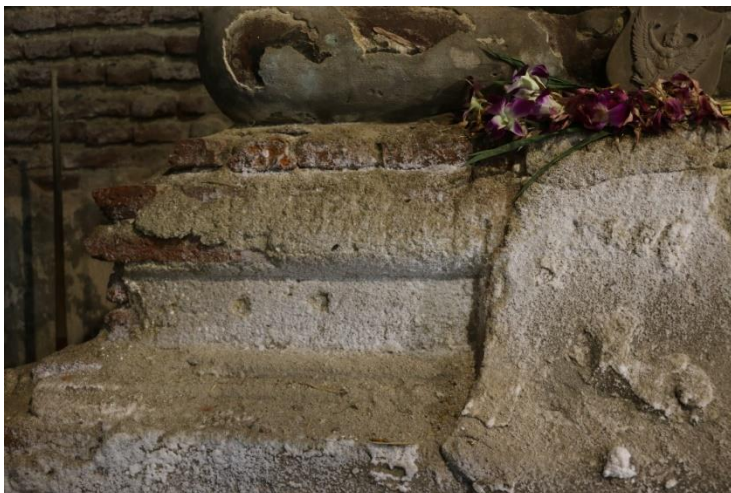
ภาพที่ 3 ครอบเกลือที่บนฐานพระพุทธรูป ผลกระทบจากความเค็มในพื้นที่ตั้งของวัดใหญ่บ้านบ่อ
