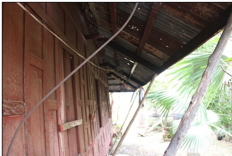
ภาพที่ 94 แขนนางทำจากเหล็กเส้นออกไปรับหลังคาบ้านสาด อุโบสถวัดจันทร์เจริญสุข
