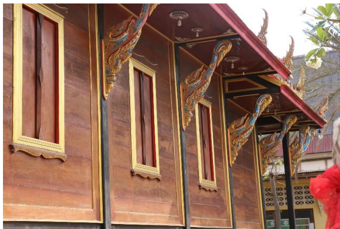
ภาพที่ 61 ฝากระดานแบ่งเป็นห้อง วัดปากอ่าวบางตะบูน
