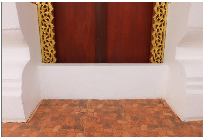
ภาพที่ 42 เชื่อนกันน้ำท่วม บริเวณประตูอุโบสถวัดบางพลี
