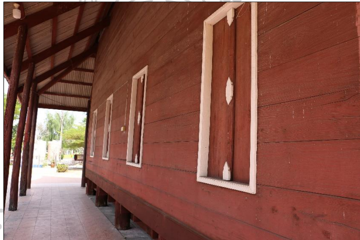
ภาพที่ 63 ฝากระดานตีเป็นแผงเดียวกันตลอด อุโบสถวัดศิริมงคล
