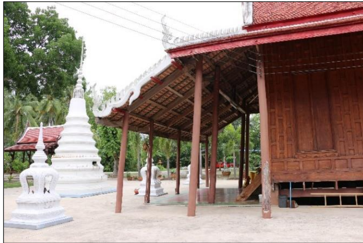
ภาพที่ 137 หลังคาจันทน์หับด้านหน้าอุโบสถวัดดอกลงกรณ์
