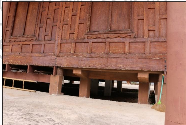
ภาพที่ 33 เสาคอนกรีตใต้อุโบสถวัดดอกลงกรณ์
