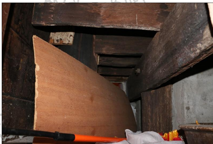
ภาพที่ 34 โครงสร้างคอนกรีต-ไม้ รองรับฐานพระประธาน อุโบสถวัดแหลมสุวรรณาราม
