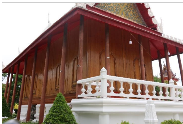
ภาพที่ 88 อุโบสถ์วัดบางจะเกร็งมีการทำแนวพาไลล้อมรอบอาคาร
