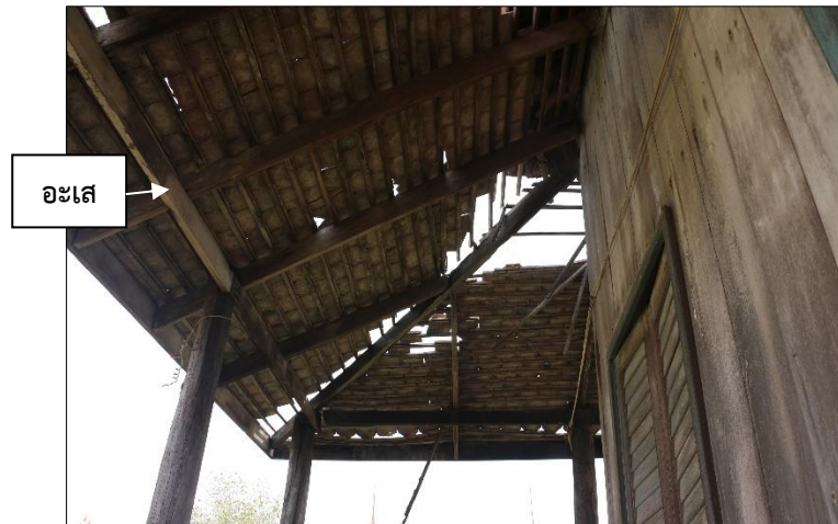
ภาพที่ 92 โครงสร้างหลังคาพาไลปีกนก อุโบสถวัดคิ่งตำหนัก
