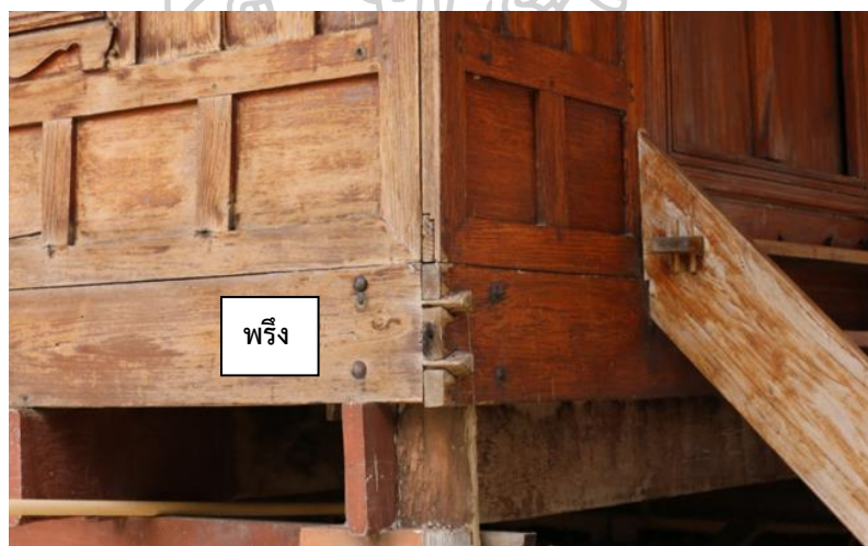
ภาพที่ 49 การเข้าพริ้งของอุโบสถวัดดอกลงกรณ์
