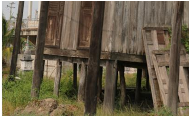
ภาพที่ 18 เสาไม้ช่วยรับโครงสร้างอุโบสถวัดคิ่งตำหนัก
