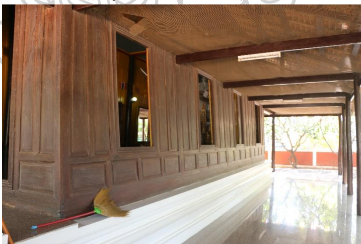
ภาพที่ 36 ฐานปูนของวัดไทรย้อย แต่เดิมเคยเป็นอาคารใต้ถุนโปร่งมาก่อน
