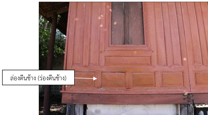
ภาพที่ 54 ตำแหน่งล่องตีนช้าง (ร่องตีนช้าง) อุโบสถวัดโคมนาราม
