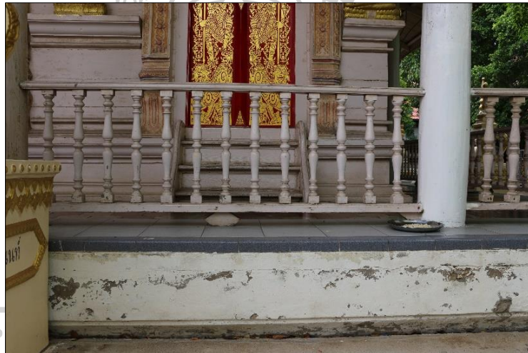
ภาพที่ 44 ฐานซ้อนกันของอุโบสถวัดแหลมสุวรรณาราม โดยฐานชั้นล่างถูกถมพื้นจนเหลือเพียงชั้นบัวหงาย
