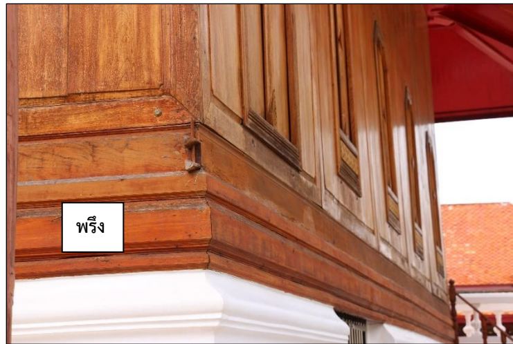
ภาพที่ 50 พริ้งแกะรูปลูกฟัก อุโบสถวัดบางจะเกร็ง
