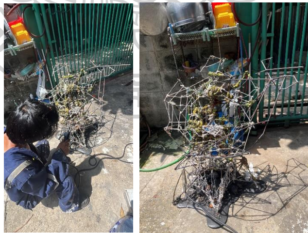
ภาพที่ 134 ขั้นตอนการ เชื่อมโครงสร้างแบบกำหนดทิศทางแสงเงา 1
