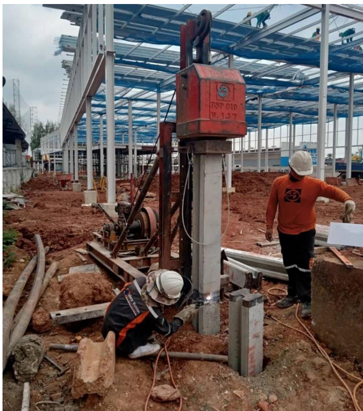
ภาพที่ 20 : แสดงรูป การตอกเสาเข็ม
