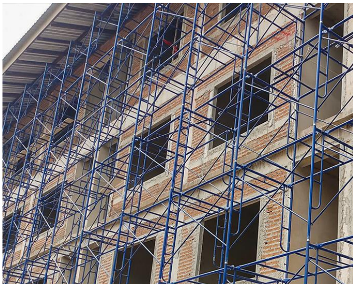
ภาพที่ 30 : แสดงรูป นั่งร้านเหล็กสำเร็จรูป
