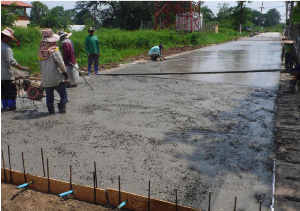
ภาพที่ 21 : แสดงรูป งานทาง (งานถนน) แหล่งที่มา : https://spcon.co.th/service_de.php?id=7 (สืบค้นเมื่อวันที่ 5/3/2566)
