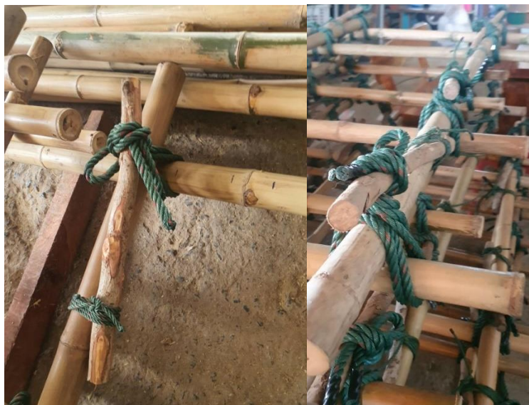
ภาพที่ 102 : ลักษณะของการผูกเชือกแบบขันชะเนาะที่เสร็จสมบูรณ์ แหล่งที่มา : ผู้วิจัย อนุรักษ์สิษฐ์ พลับขจร (ถ่ายเมื่อวันที่ 15/8/2566)
