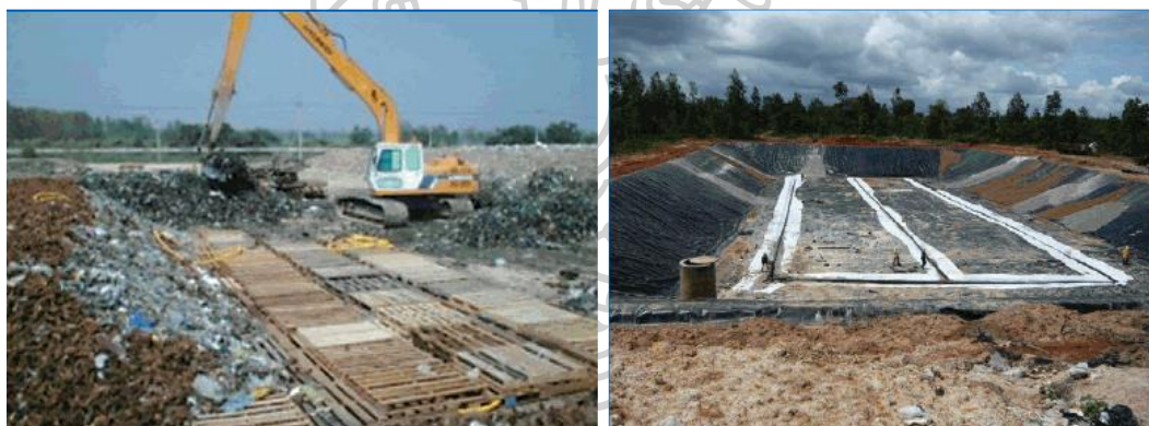
ภาพที่ 2.7 ระบบฝังกลบอย่างถูกหลักสุขาภิบาล
