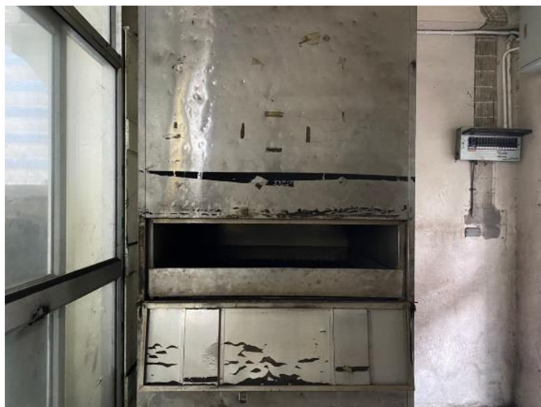
ภาพที่ 20 ภาพแสดงตู้โรยผงแอสฟัลต์ต้มและอุปกรณ์ที่ใช้ในการโรยผงแอสฟัลต์ต้ม
