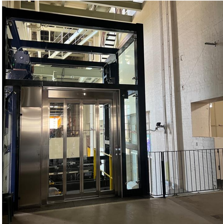
ภาพที่ 19 ภาพลิฟท์โดยสารที่สร้างขึ้นภายในตัวอาคารโรงไฟฟ้าไวท์เบย์ (White Bay Power Station)
