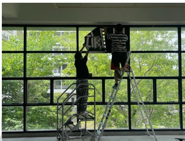
ภาพที่ 227 การติดตั้งสติ๊กเกอร์ PVC บนผนังกระจก ที่มา: ภาพถ่ายโดย ชนธร สรรพกิจงานง
