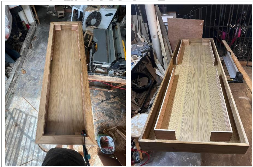
ภาพที่ 15 ขึ้นรูปกล่องไม้ตามขนาดที่ออกแบบไว้ 190 x 60 เซนติเมตร ที่มา ภาพถ่ายโดยผู้สร้างสรรค์
