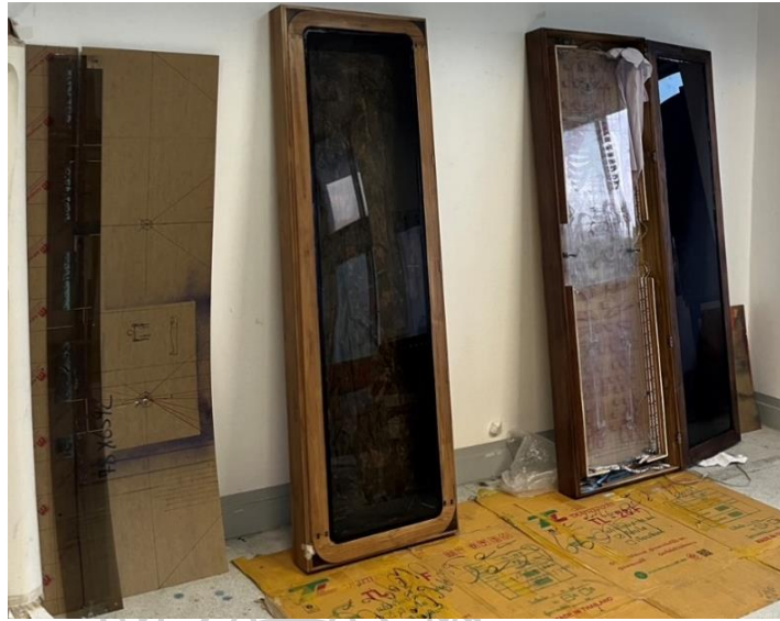
ภาพที่ 38 การติดฝาด้วยแผ่นอะคริลิกสีดำด้วยกาวซิลิโคน ที่มา ภาพถ่ายโดยผู้สร้างสรรค์
