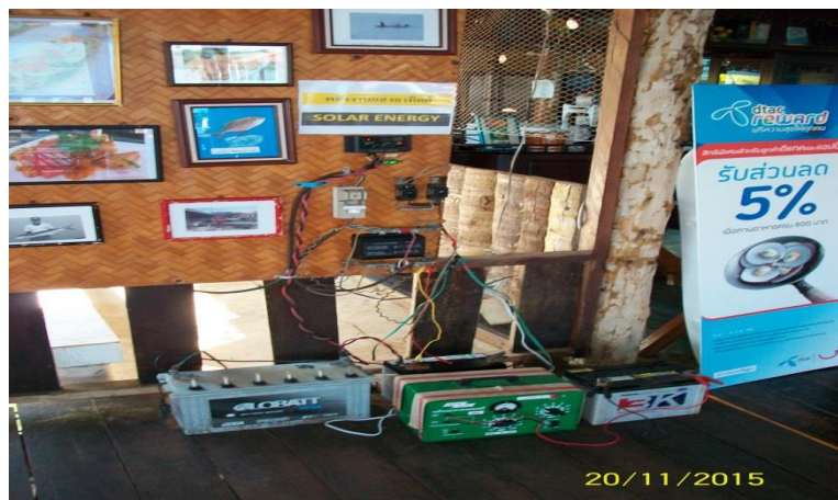
ภาพที่ 10 ตัวอย่างวิธีการต่อวงจรพลังงานแสงอาทิตย์อย่างง่ายของ เกาะหมาก ซีฟู้ด เพื่อให้นักท่องเที่ยวหรือผู้ที่สนใจได้มาศึกษาถึงวิธีการต่อวงจร
