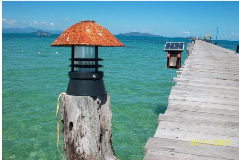
ภาพที่ 2 การใช้พลังงานแสงอาทิตย์มาใช้เป็นไฟส่องสว่างทางเดินของ ชินามอน อาร์ท รีสอร์ท แอนด์ สปา
