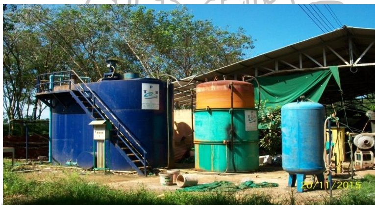
ภาพที่ 14 ถังหมักและกักเก็บก๊าซภายใน เอนเนอร์ยี พาร์ค
