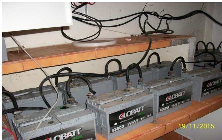
ภาพที่ 4 การนำเอาแบตเตอรี่ที่ไม่ใช้แล้วนำกลับมาใช้เป็นอุปกรณ์เก็บประจุไฟฟ้าที่ได้จากแสงอาทิตย์ ในบริเวณสระว่ายน้ำ เกาะหมาก รีสอร์ท
