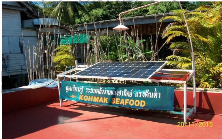
ภาพที่ 3 การใช้พลังงานแสงอาทิตย์มาใช้เป็นไฟส่องสว่างภายในร้านอาหารเกาะหมาก ซีฟู้ด และพิพิธภัณฑ์เกาะหมาก
