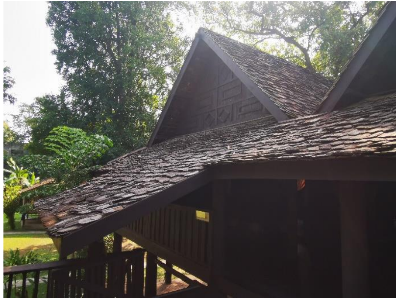
ภาพที่ 3.16 ภาพถ่ายไม้แป้นเกล็ด เรือนไทลื้อ (หม่อนตูด)
