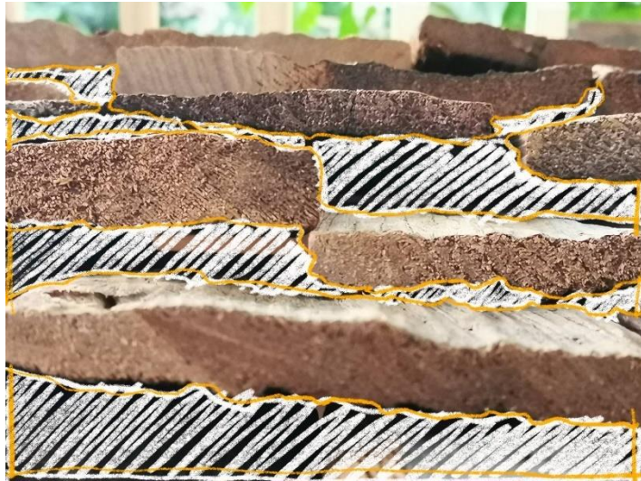
ภาพที่ 4.13 พื้นที่ว่างระหว่างแผ่นของกลุ่มตัวอย่างแผ่นแป้นเกล็ดไม้สักแบบดั้งเดิม
