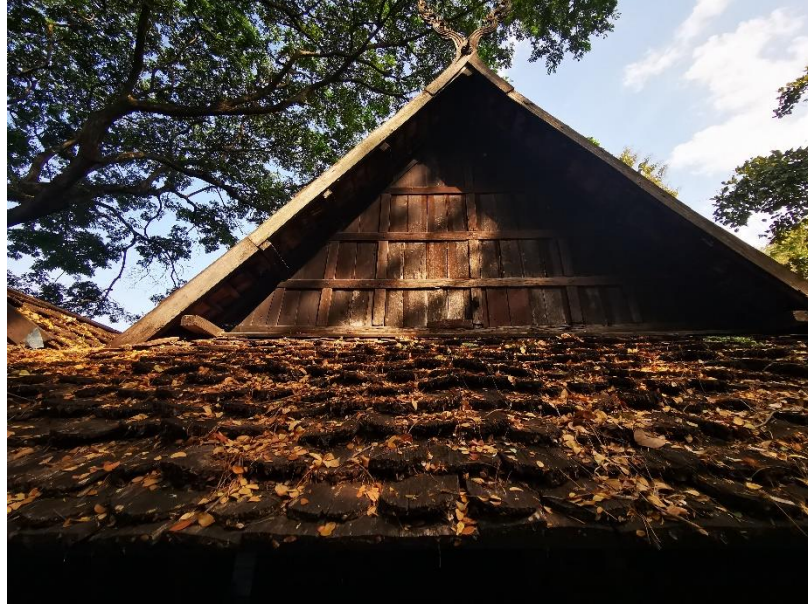
ภาพที่ 3.22 ภาพถ่ายไม้แป้นเกล็ด เรือนกาแล (อ้อยผัด)
