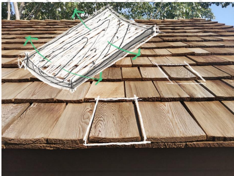
ภาพที่ 3.32 ตัวอย่างแผ่นหลังคาแป้นเกล็ดที่เกิดการเปลี่ยนแปลงทางขนาดและรูปร่าง
