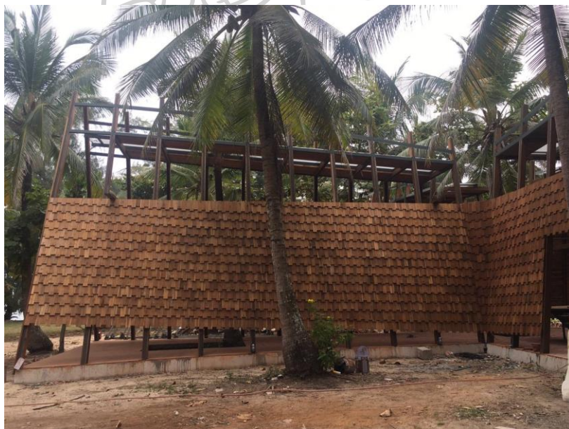
ภาพที่ 3.40 การติดตั้งไม้แป้นเกล็ดแบบประยุกต์
