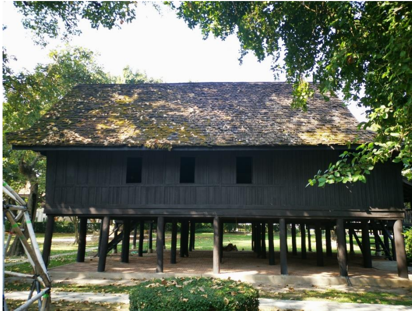
ภาพที่ 3.18 ภาพถ่ายด้านข้าง เรือนไถลื้อ (หม่อนตุ๊ด)
