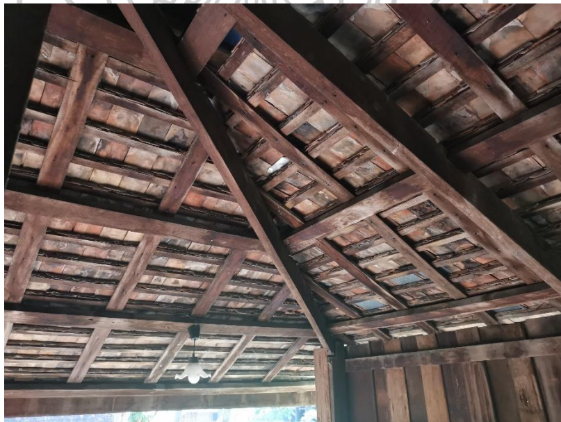
ภาพที่ 2.25 การบูรณะเบื้องดินขอ ภายในตัวเรือนชาวเชียงใหม่ (พญาปลั่งกา)
