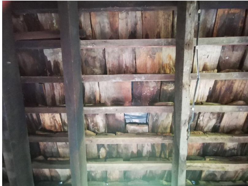
ภาพที่ 3.20 ภาพถ่ายใต้ไม้แป้นเกล็ด เรือนไถลื้อ (หม่อนตุ๊ด)
