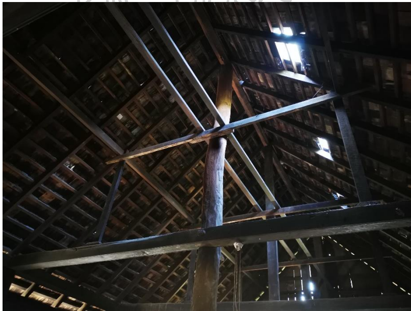
ภาพที่ 3.19 ภาพถ่ายโครงสร้างชุดบน ใต้ไม้แป้นเกล็ด เรือนไถลื้อ (หม่อนตุ๊ด)
