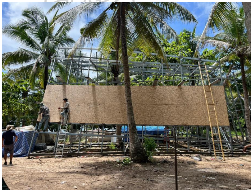
ภาพที่ 3.38 การติดตั้งแผ่น OSB หนา 15 มม. บนโครงสร้างเหล็ก @ 1.20 ม. X 0.60 ม. และทำ ทับด้วยเซนไดรท์ 2 รอบ
