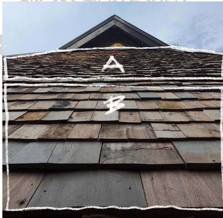
ภาพที่ 3.42 การติดตั้งแผ่นแป้นเกล็ดบ้านพักอาศัยที่ผสมผสานระหว่างแผ่นแป้นเกล็ดเก่ากับแผ่นแป้นเกล็ดที่ทำขึ้นใหม่จากไม้พื้นหรือไม้ฝา
