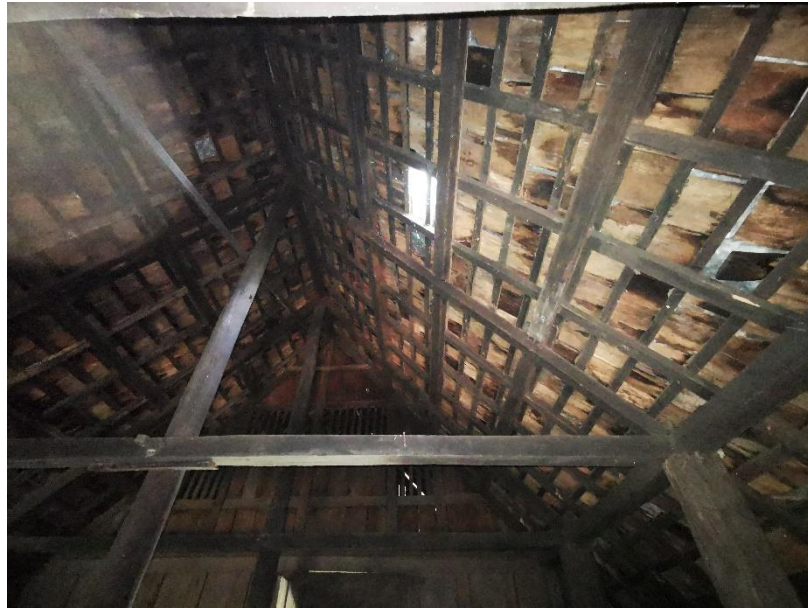
ภาพที่ 3.24 ภาพถ่ายโครงสร้างชุดบน ใต้ไม้แป้นเกล็ด เรือนกาแล (อุ้ยผัด)
