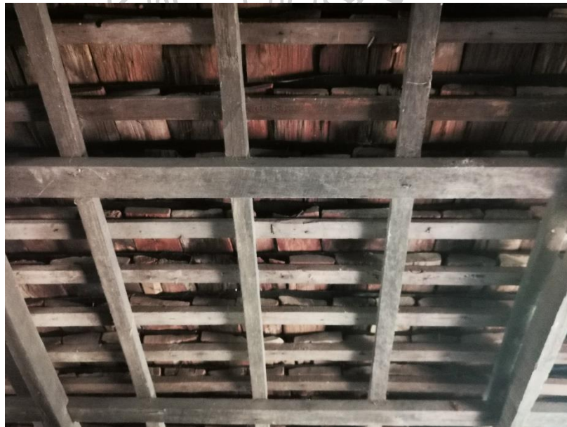
ภาพที่ 3.25 ภาพถ่ายใต้ไม้แป้นเกล็ด เรือนกาแล (อุ้ยผัด)
