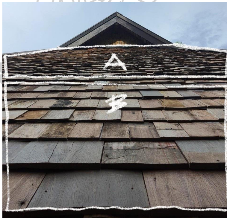
ภาพที่ 3.43 ตัวอย่างแป้นเกล็ดที่แปรรูปแบบดั้งเดิม (A) และการแปรรูปแบบประยุกต์ (B)
