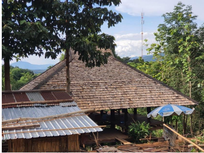
ภาพที่ 3.41 หลังคาแป้นเกล็ดทางภาคเหนือ ออกแบบโดยยางนาสตูดิโอ
