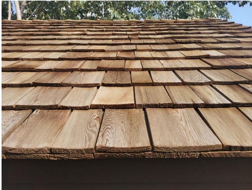
ภาพที่ 3.31 การติดตั้งแผ่นแป้นเกล็ด Swensen's Flagship Nan สันฐาน เวียงสิมา
