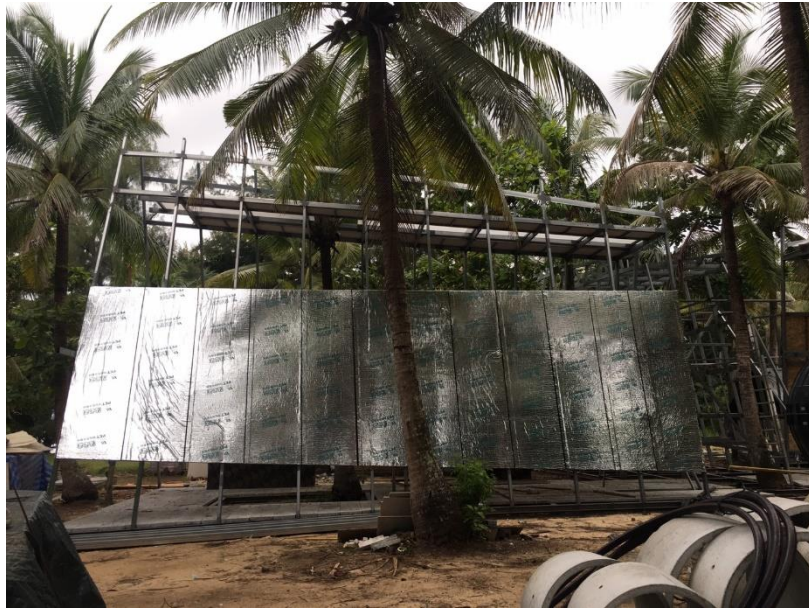
ภาพที่ 3.39 การติดตั้งแผ่นยางกันซึม Waterproof Membrane
