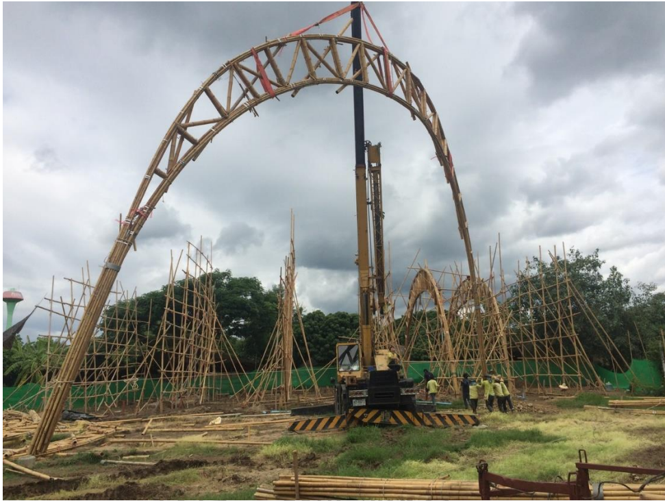
รูปภาพที่ 36 การขึ้นโครงไม้ Panyaden International School, photo by ArchDaily
