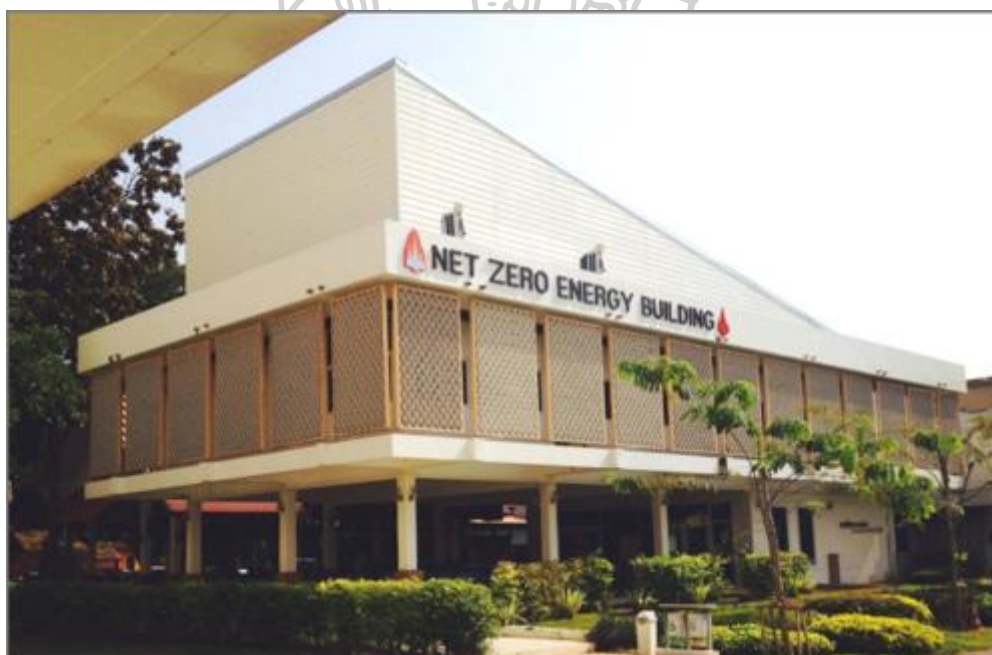
รูปภาพที่ 10 อาคาร Net Zero Energy Building กองสื่อสาร องค์กร มหาวิทยาลัยขอนแก่น
