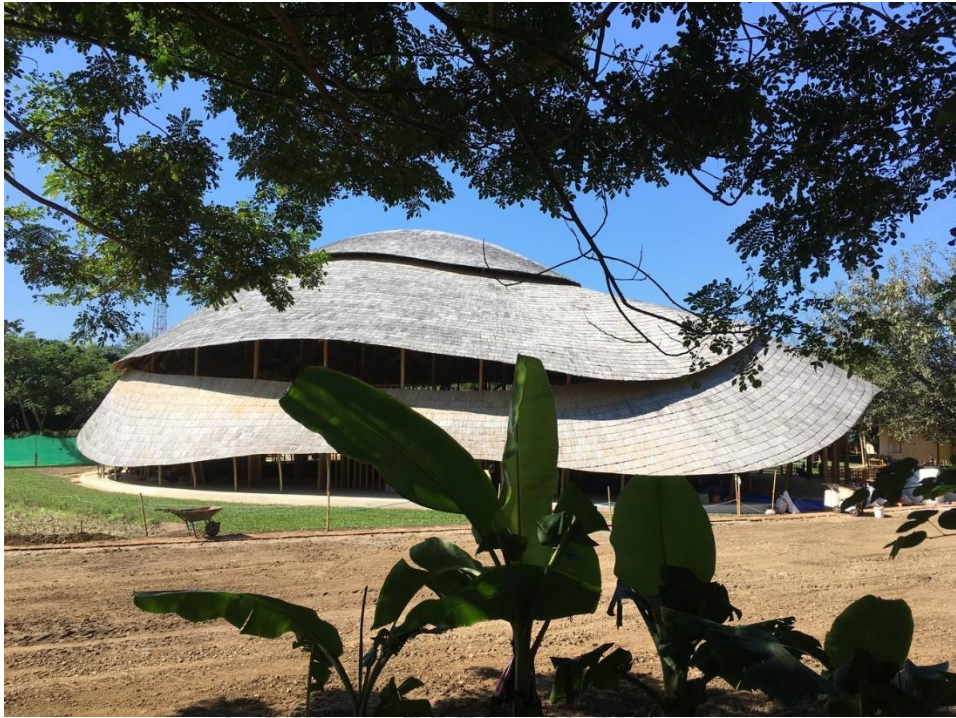
รูปภาพที่ 38 มุงหลังคา Hall of Panyaden International School, photo by ArchDaily
