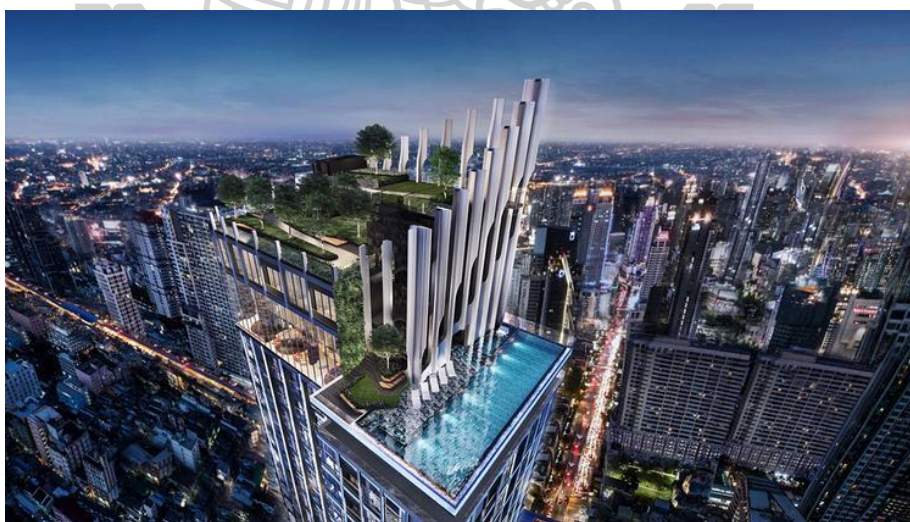
ภาพที่ 38 ภาพแสดงอาคารคอนโดมิเนียม พาร์ค ออริจิ้น ราชเทวี (ที่มา : จาก https://img.iproperty.com.my/angel/750x1000-fit/wp-content/uploads/sites/6/2024/04/LC230319_ORG_Park-Origin_RCTW.jpg )
