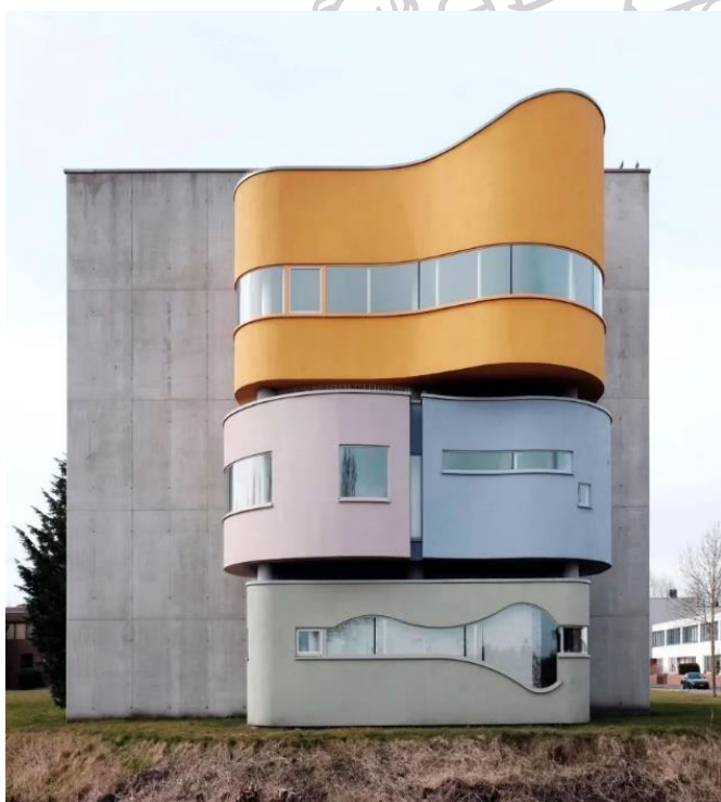
Figure 118 ภาพบ้าน Wall House 2 (Bye House) โดย John Hejduk (1973-76) ที่มา https://archeyes.com/the-wall-house-ii-by-john-hejduk-a-structural-symphony/
