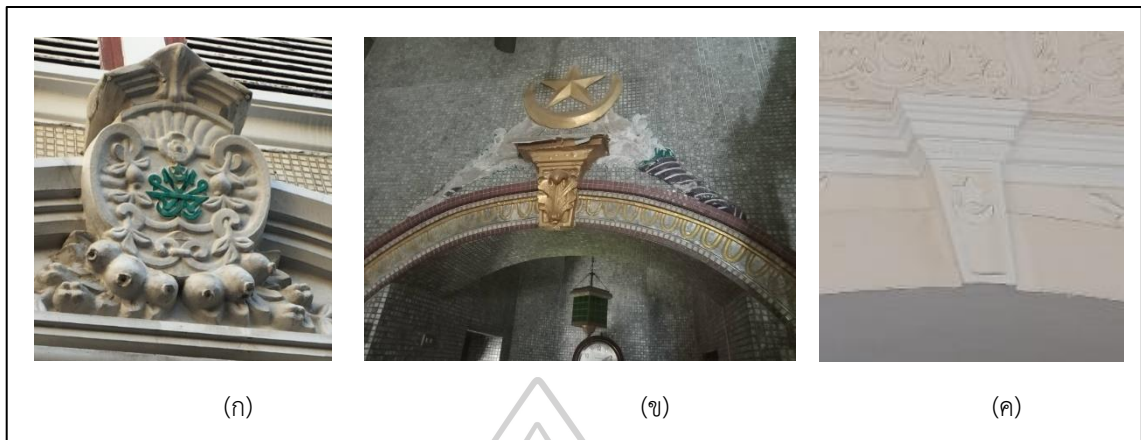
ภาพที่ 86 ตราดวงดาวและพระจันทร์เสี้ยวที่ประดับบนมัสยิดที่ออกแบบโดยนายกาเซ็ม แพลน
