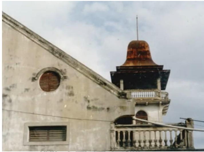
ภาพที่ 64 ช่องระบายอากาศบริเวณหน้าจั่วของมัสยิดดารอสอาดะห์ หลังเดิม (ภาพจาก มัสยิดดารอสอาดะห์ (ปากลัด พระปะแดง)
