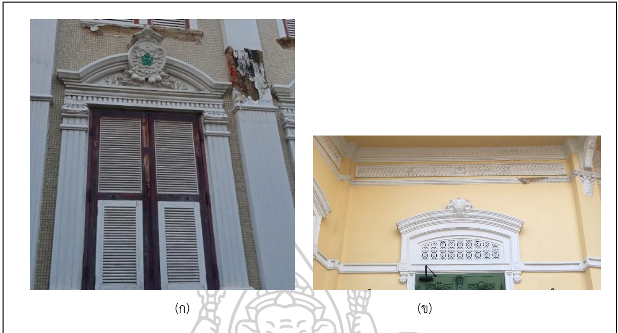
ภาพที่ 130 ลายฟันเรียง (Dentil) บนผนังด้านนอกของมัสยิดดารุลออบิดีน ตอกจันทน์ และมัสยิดบางอ้อ (ก) ทรายฟันเรียง (Dentil) ที่ประดับอยู่บนฐานซุ้มหน้าต่างของมัสยิดดารุลออบิดีน ตอกจันทน์ (ข) ทรายฟันเรียง (Dentil) ที่ประดับอยู่ด้านบนสุดของผนังด้านนอกมัสยิดบางอ้อ
