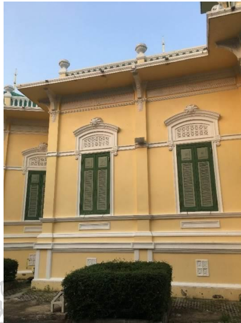
ภาพที่ 120 ซายคาลังคาแบนที่ยื่นออกมาจากหลังคาของมัสยิดบางอ้อ
