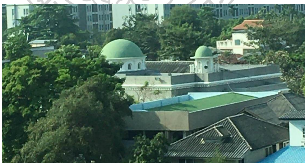
ภาพที่ 80 ภาพถ่ายด้านบนของมัสยิดหลวงอันซอริซซุนนะห์ แสดงให้เห็นถึงการสร้างระเบียงที่บปกปิดหลังคาลาด
