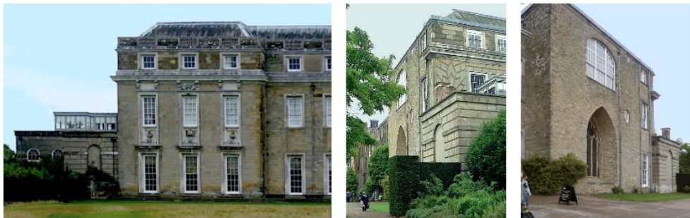
ภาพที่ 78 รูปด้านอาคาร
