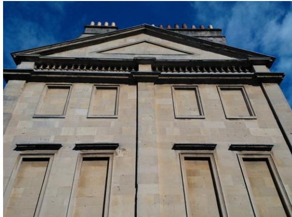
ภาพที่ 30 ตัวอย่างบ้านที่ก่ออิฐปิดหน้าต่างเดิมหลังที่ 2 ที่มา : https://www.flickr.com/photos/10349050@N04/7905627302/
