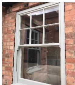
ภาพที่ 4 Sash window
