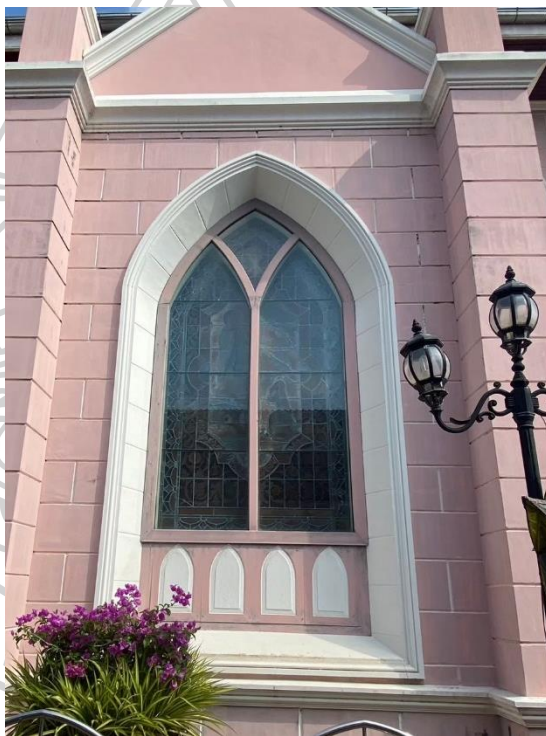
ภาพที่ 110 ภาพกระจกภายนอกที่สร้างขึ้นเพื่อป้องกันกระจกสีด้านใน ที่มา: ผู้วิจัย, 2567
