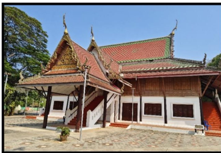
รูปที่ 16 ศาลาการเปรียญวัดทุ่งหญ้าคมบาง บริเวณหลังคามีเลข 104 ระบุถึงช่วงเวลาที่สร้าง ศาลาการเปรียญ ถ่ายเมื่อ วันที่ 5 เมษายน 2567
