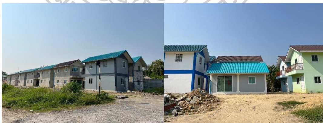
ภาพที่ 24 และ ภาพที่ 25 บ้านมั่นคงในชุมชนฟ้าใหม่ร่วมใจพัฒนา
