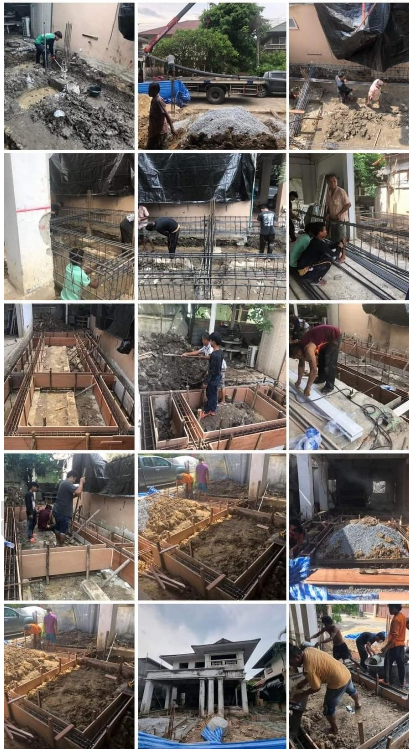
ภาพที่ 42 การก่อสร้างต่อเติม ปรับปรุง บ้านในโครงการเพอร์เฟกเพลสรามคำแหง
