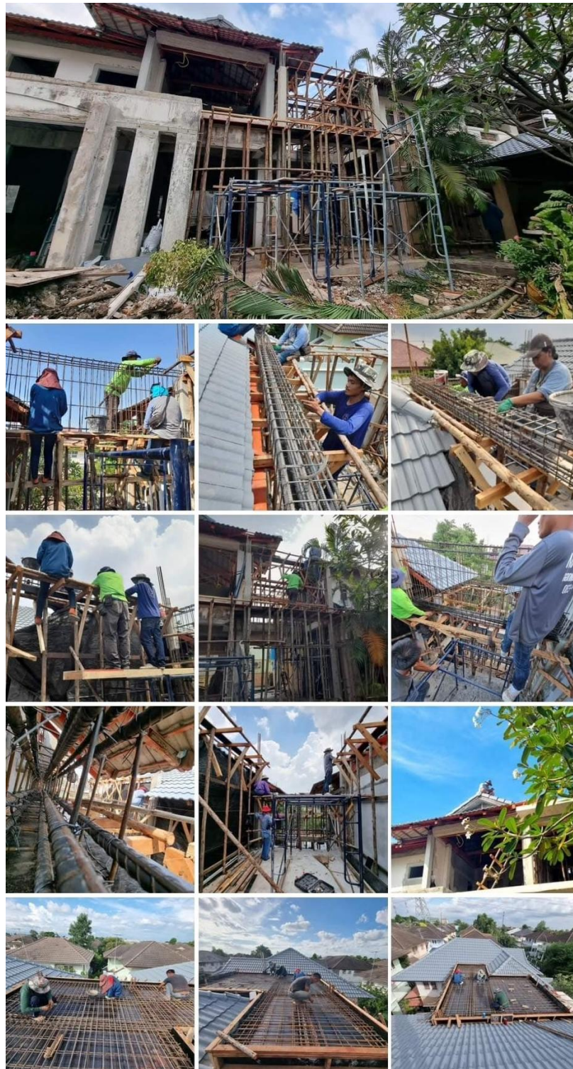
ภาพที่ 41 การก่อสร้างต่อเติม ปรับปรุง บ้านในโครงการเพอร์เฟกเพลสรามคำแหง
