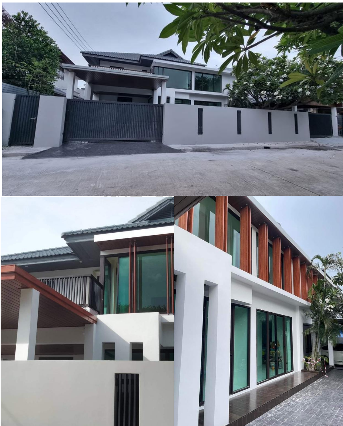
ภาพที่ 43 หลังการดำเนินการรื้อถอน ดำเนินการสร้างสรรค์สถาปัตยกรรมใหม่ทั้งหมด สำหรับบ้านทั้งสองหลัง
