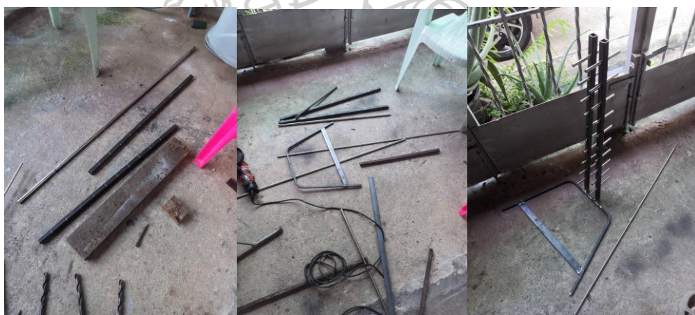
ภาพที่ 55 ขึ้นโครงเหล็ก
