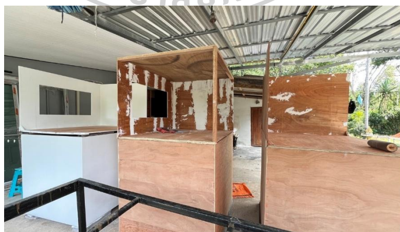
ภาพที่ 36 การประกอบโครงสร้างไม้อัดให้เป็นห้อง
