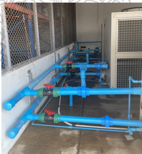
ภาพที่ 60 การเดินท่อน้ำซิลเลอร์หลังปรับปรุง
