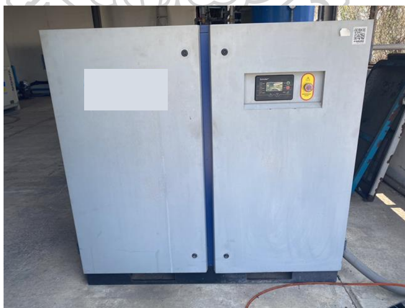
ภาพที่ 34 เครื่องปั๊มลมที่ทำความดันให้กับแผนกผลิตบรรจุภัณฑ์
