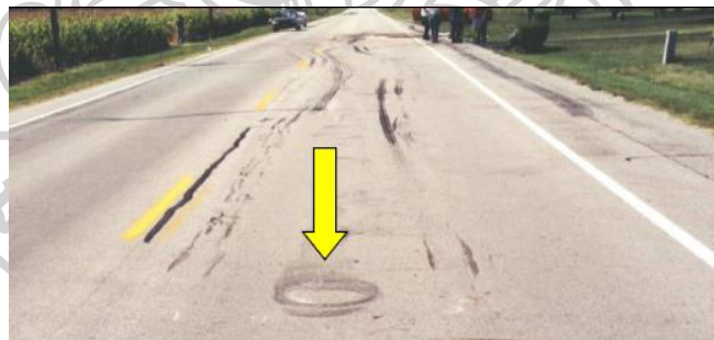
ภาพที่ 5 ร่องรอยของการมีชิ้นส่วนกดลงกับพื้นถนน ที่มา: สำนักสวัสดิภาพการขนส่งทางบก กรมการขนส่งทางบก และ กองทุนเพื่อความปลอดภัยในการใช้รถใช้ถนน(2560:6-12)
