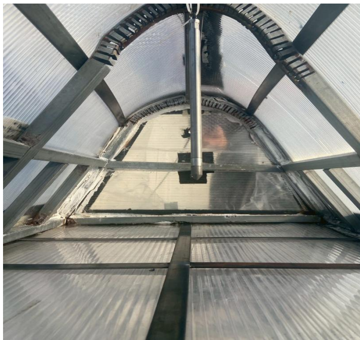
รูปที่ 48 แก้ไขโครงสร้างภายในหลังเกิดความเสียหายจากแรงดันอากาศ
