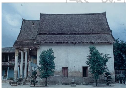
ภาพที่ 51 (ซ้าย) อุโบสถ (เก่า) วัดบางสะแก นนทบุรี
