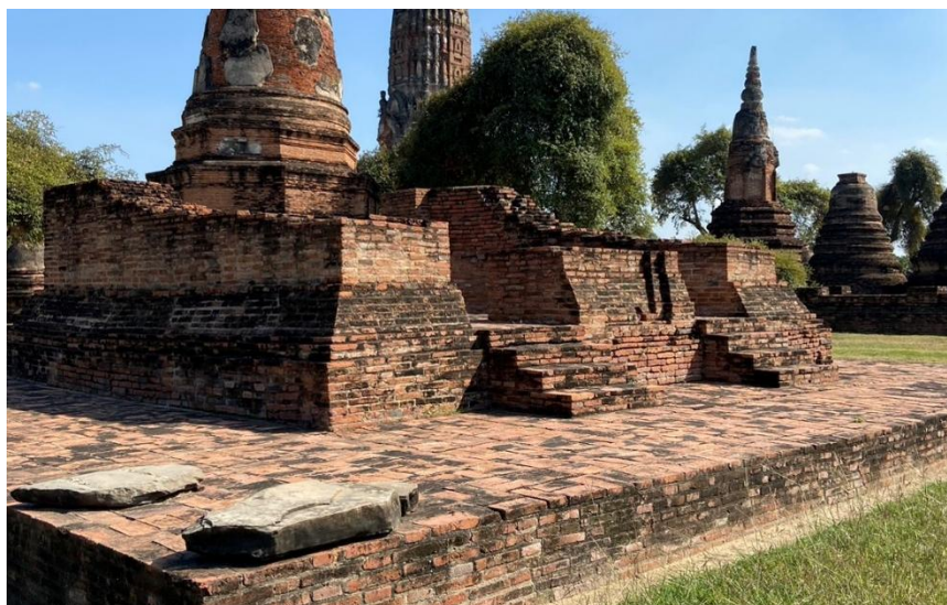
ภาพที่ 60 อาคารผังสี่เหลี่ยมจัตุรัสภายในวัดที่อาจเป็นมณฑป
