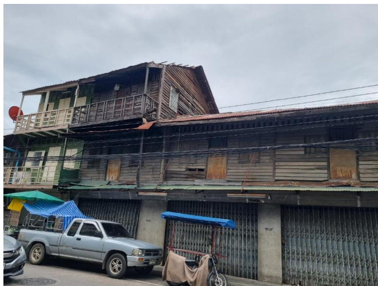
ภาพที่ 33 อาคารตึกแถวไม้บนถนนวชิรปราการ
