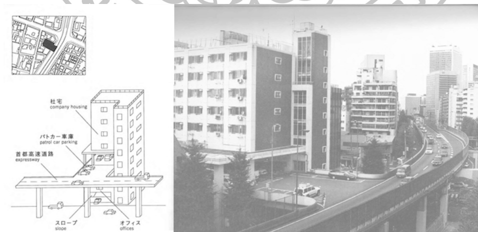
ภาพที่ 5 Expressway Patrol Building การจัดการพื้นที่ว่าง : การซ้อนทับกันของหน้าที่(Function)
