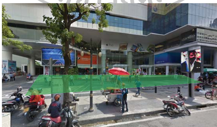
ภาพที่ 18 พื้นที่ด้านหน้าอาคารยูไนเต็ดเซ็นเตอร์ (ภาพถ่ายจากการสำรวจภาคสนามโดยผู้วิจัย, 2558)
