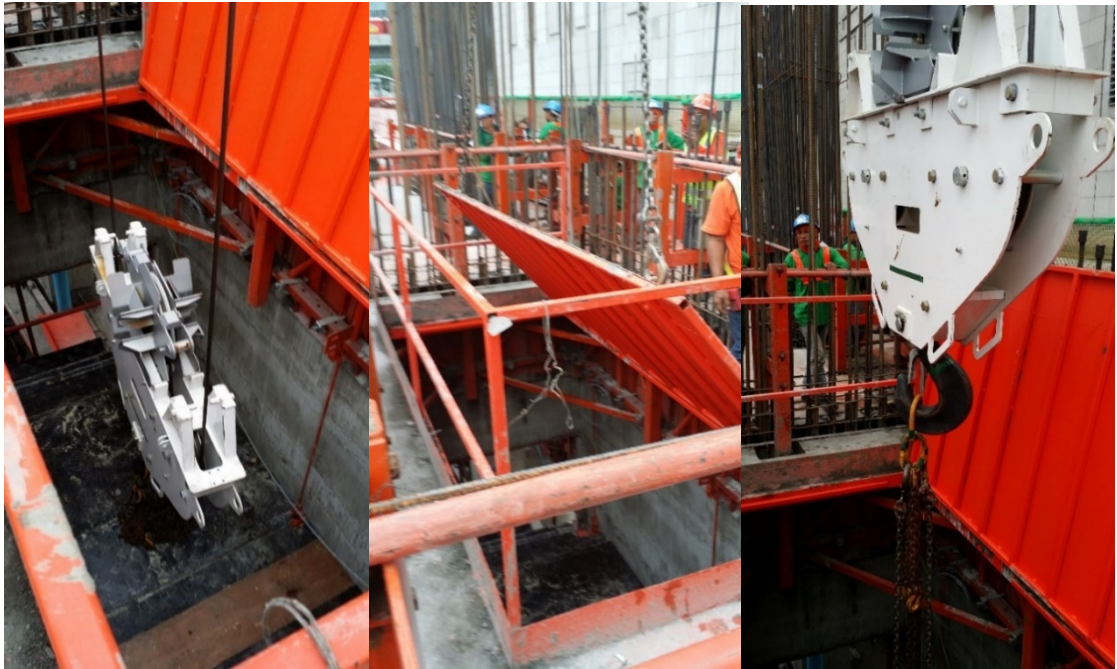
รูป 113 การปฏิบัติงานตาม Work Method Statement (ติดตั้งบันได)
