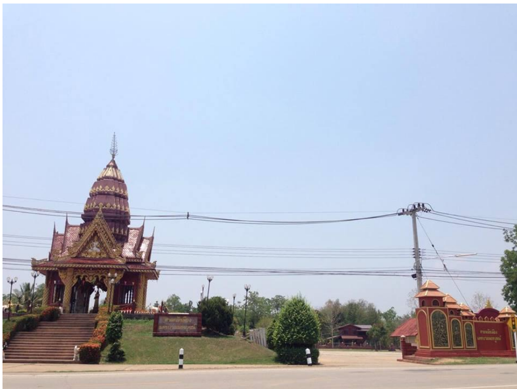
ภาพ บริเวณศาลหลักเมืองเพชรบูรณ์ ซึ่งมีการบูรณะยกพื้นปรับระดับและสร้างอาคารหลังคาคลุมหลังใหม่แทนหลังคาสักกะสีแบบเดิม
