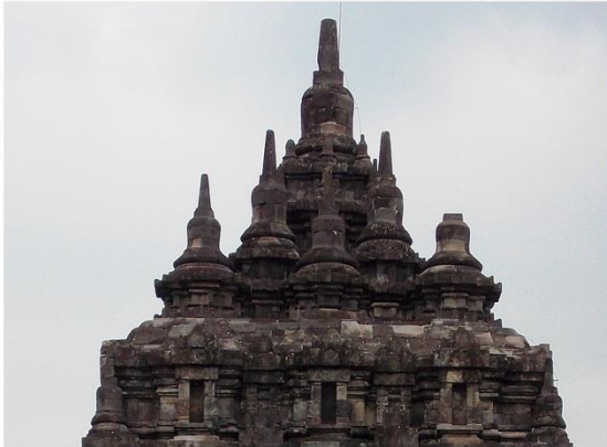
ส่วนยอดอาคาร (มุมมองด้านทิศใต้)
