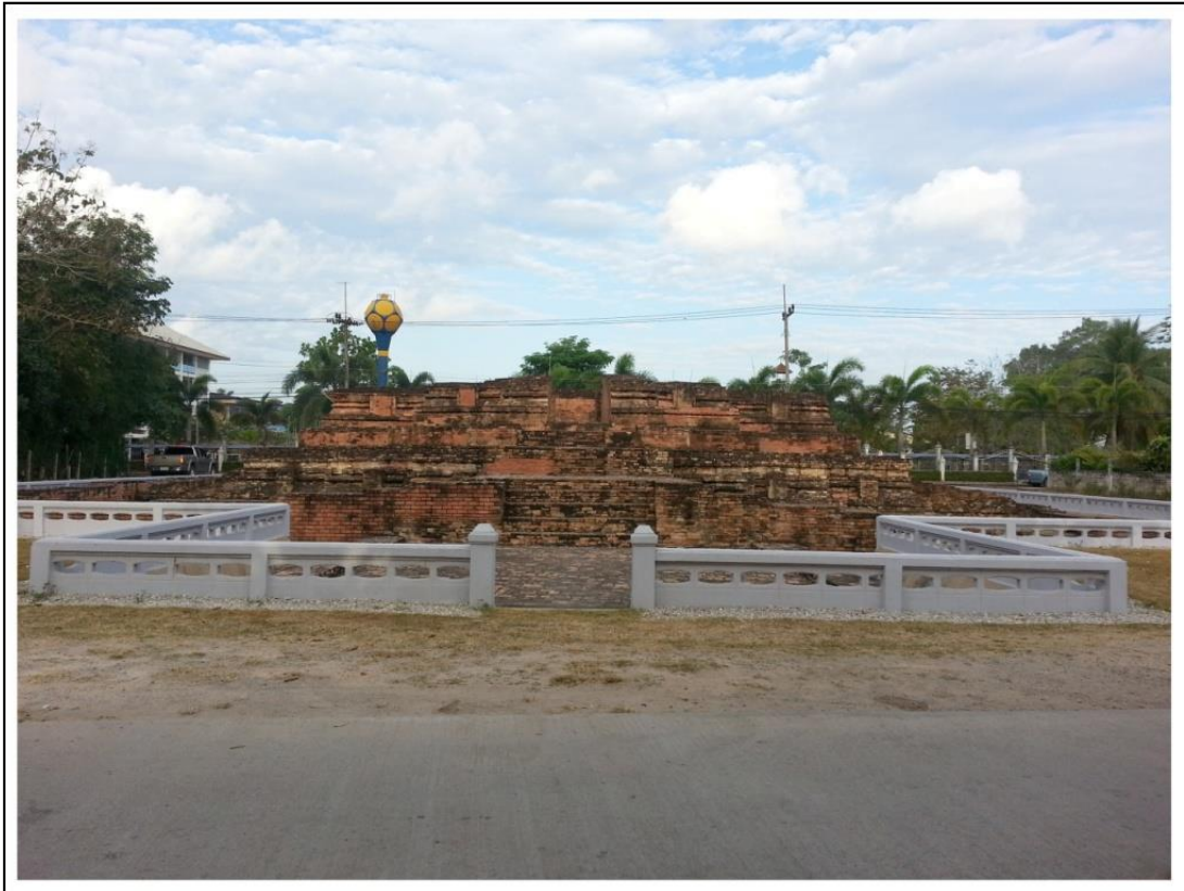
ภาพที่ 188 ฐานอาคารวัดหลง ด้านทิศตะวันออก
