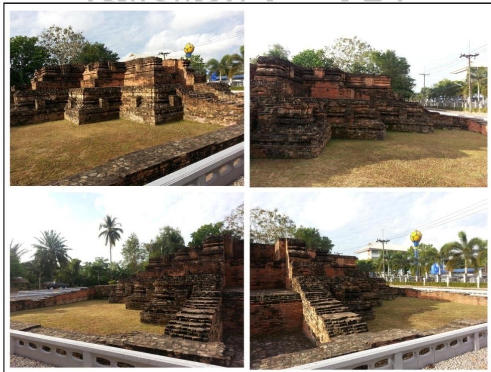
ภาพที่ 193 แสดงรายละเอียดส่วนฐานอาคารวัดหลง ด้านทิศเหนือ
