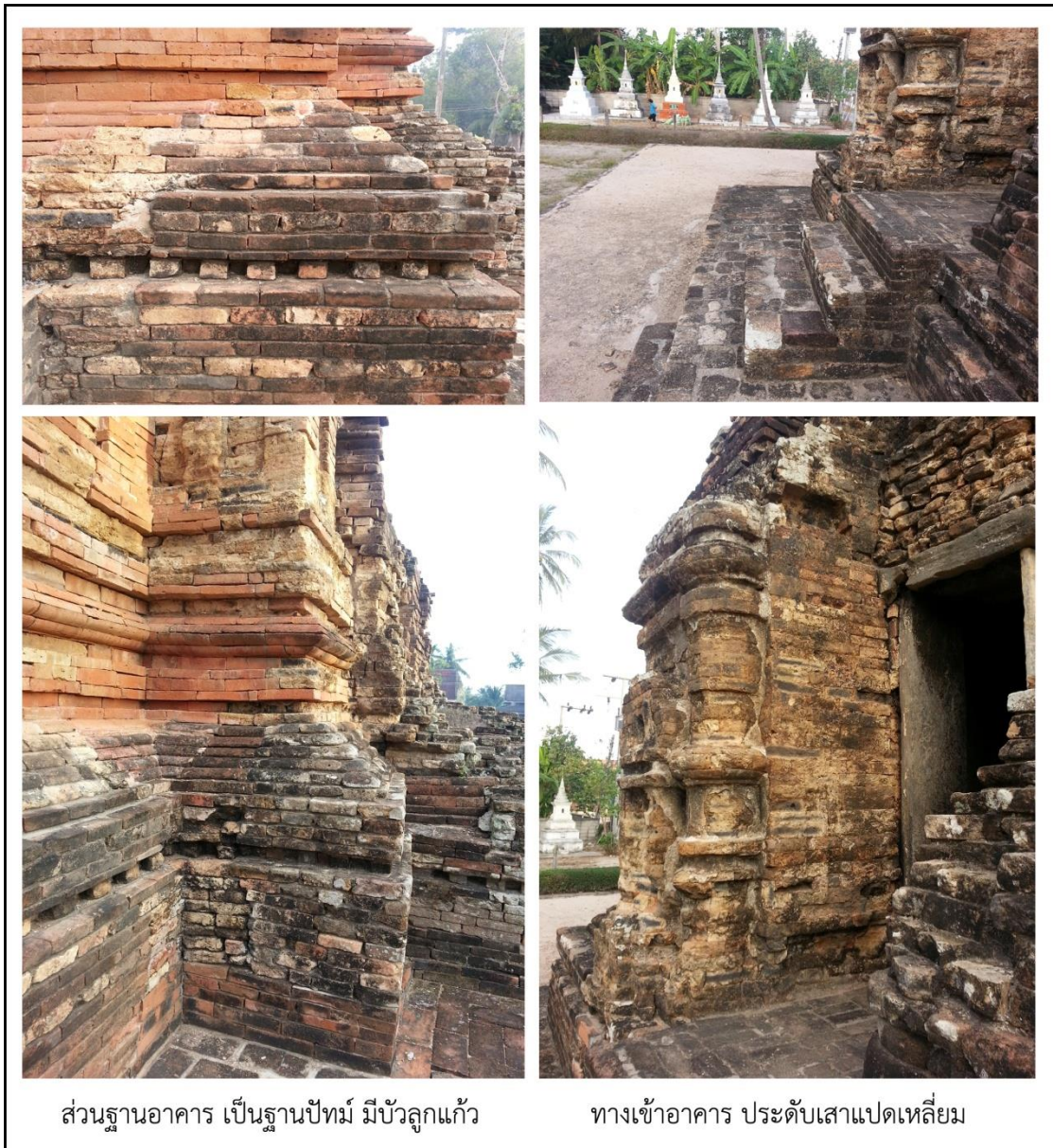
ภาพที่ 177 แสดงรายละเอียดส่วนฐานและซุ้มประตูทางเข้าของอาคารวัดแก้ว ด้านทิศใต้
