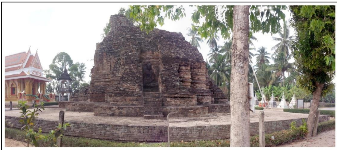
ภาพที่ 170 สภาพปัจจุบัน อาคารวัดแก้ว ด้านทิศเหนือ
