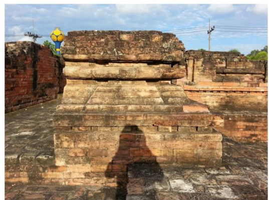
ฐานอาคารของทางขึ้นครมคฤหะประธาน
