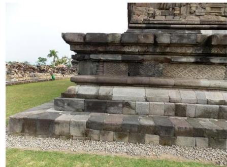
ฐานอาคาร
