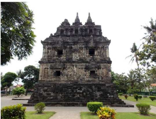
อาคราด้านทิศเหนือ
