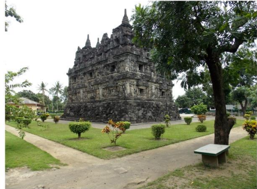
มูมอาคราด้านทิศตะวันตก
