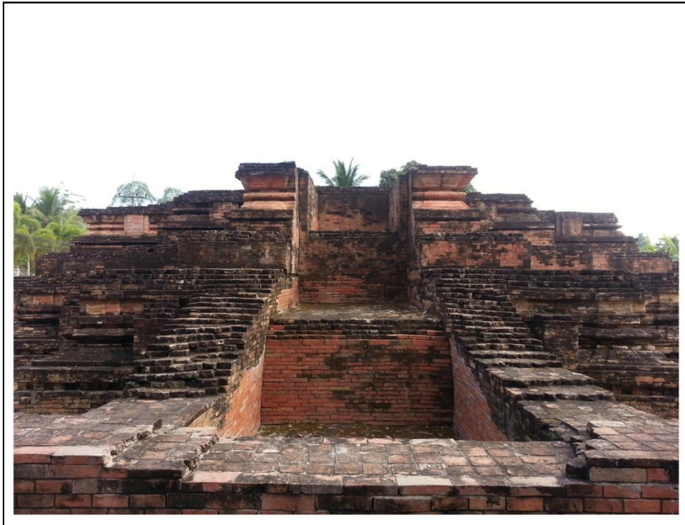
ภาพที่ 196 แสดงฐานอาคารวัดหลง ด้านทิศใต้
