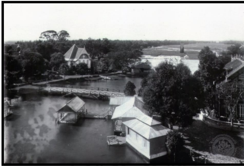
ภาพที่ 27 ภาพถ่ายเก่า แสดงให้เห็นถึงกลุ่มอาคารแบบตะวันตก และสิ่งก่อสร้างต่างๆ จำนวนหนึ่ง ภายในพระราชวังบางปะอิน ที่มา : สำนักหอจดหมายเหตุแห่งชาติ, “พระราชวังบางปะอิน - พระนครศรีอยุธยา”
