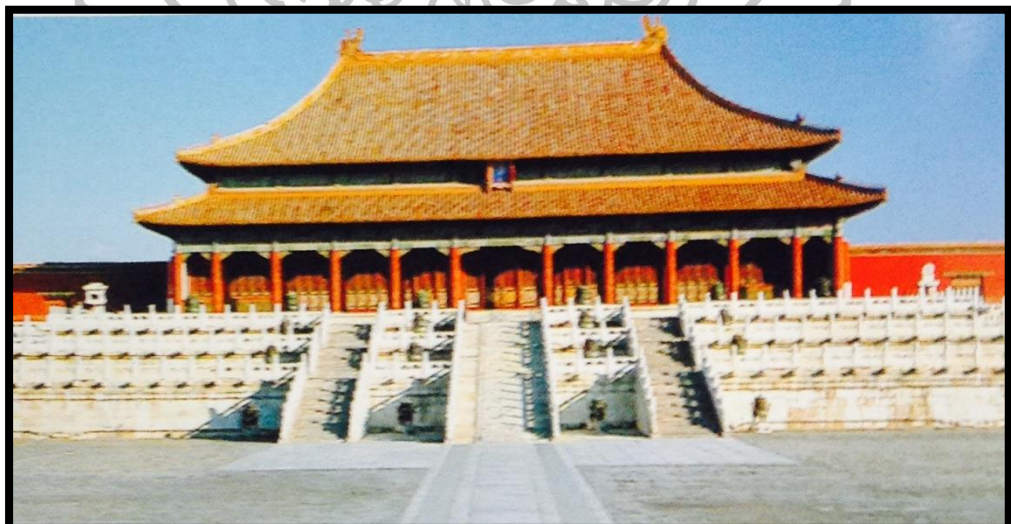
ภาพที่ 85 ท้องพระโรง ที่พระราชวังหลวง กรุงปักกิ่ง ประเทศจีน อยู่ในผังสี่เหลี่ยมผืนผ้า และใช้ชุดหลังคาแบบฉงเอี้ยนอู่เตี้ยนตั้ง(หลังคาซ้อนกัน 2 ชั้น)
