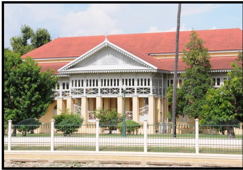
ภาพที่ 95 ด้านหลังของสภาคารราชประยูร ที่หน้าจั่วเป็นไม้ฉลุลายตอบริบกับแม่น้ำเจ้าพระยา (จากการลงภาคสนามเมื่อ 29 พฤษภาคม 2557)
