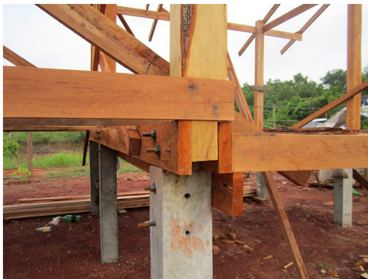
ภาพที่ 1 การเชื่อมต่อของการต่อไม้
