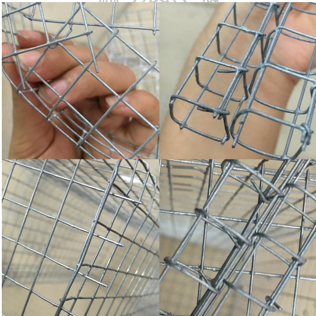
ภาพที่ 20 ภาพแสดงกระบวนการตัดและมัดลวดตาข่าย
